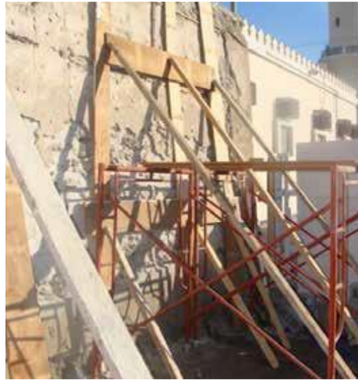
صورة رقم 129: تدعيم الجدران المنتفخة
