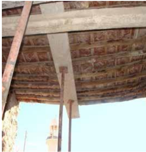
صورة رقم 73: تدعيم العناصر الحاملة للقبة
