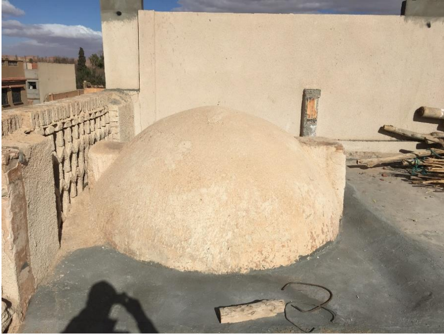
صورة رقم 54: القببة بعد عملية الترميم المصدر: مكتب الدراسات أحمد تبراخ
