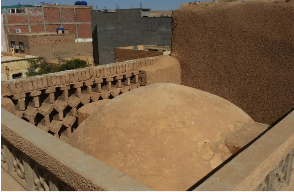
صورة رقم 53: القببة قبل عملية الترميم المصدر: مكتب الدراسات أحمد تبراخ
