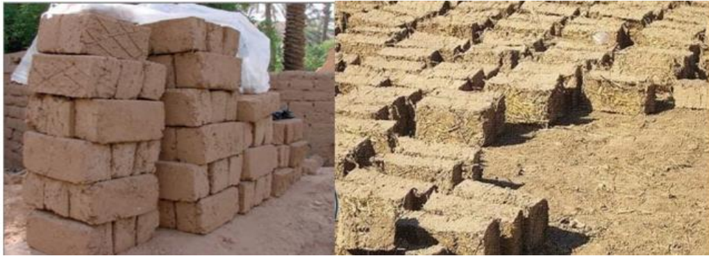
صورة رقم 40 : طريقة تجفيف اللبنات
