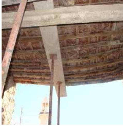
صورة رقم 130: تدعيم العناصر الحاملة للقبة
