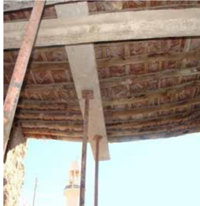
صورة رقم 109: تدعيم العناصر الحاملة للقبة
