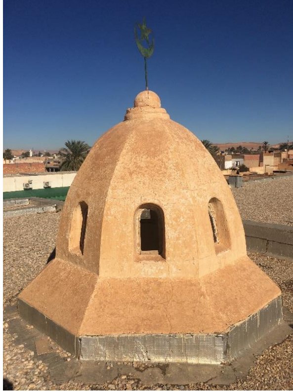
صورة رقم 47: المنظر الخارجي القبة رقم 02 لمدرسة احمد شطة المصدر : الباحث
