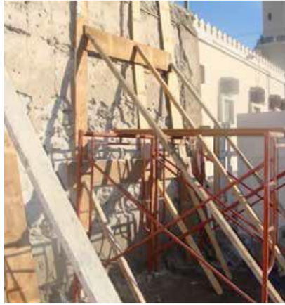
صورة رقم 108: تدعيم الجدران المنتفخة
