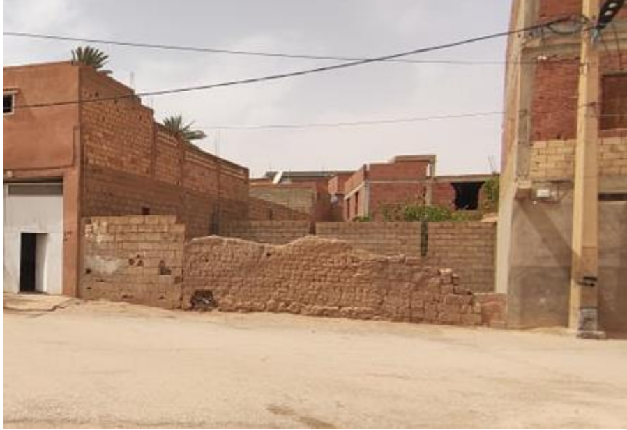
صورة رقم 38 : جدار محلي مبني بالطوب المصدر: الطالب
