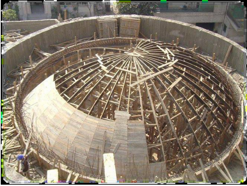
صورة رقم 05 : هيكل انشائي لقبية المصدر: د. ثرية عاشور
