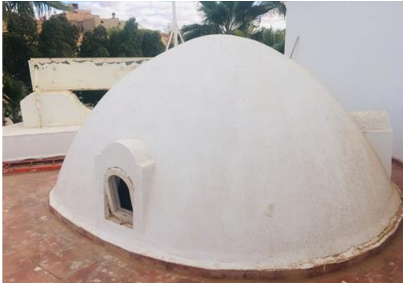
صورة رقم 51: قبة فندق مرحبا المصدر : الباحث
