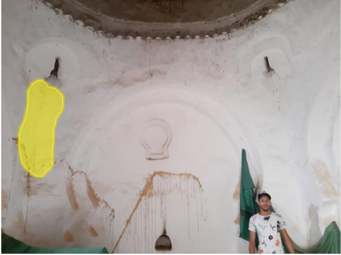
صورة رقم 70: شروخ عميقة نوعا ما على مستوى العناصر الحاملة للقببة
