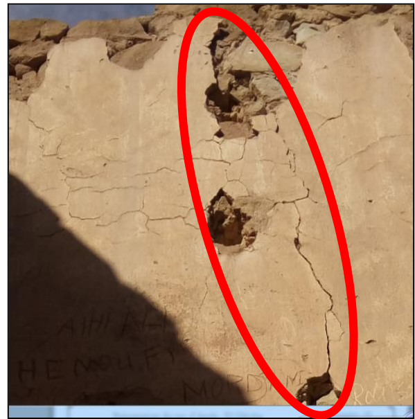
Figure 204: les fissurations dans les murs source : Auteure
