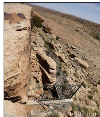
Figure 110: mal placement de la clôture -source :Google
