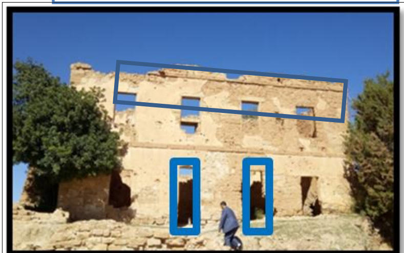
Figure 198 : les ouvertures du moulin hydraulique
