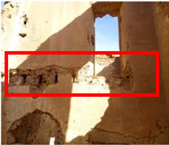
Figure 199: la fissuration des murs source : Auteure
