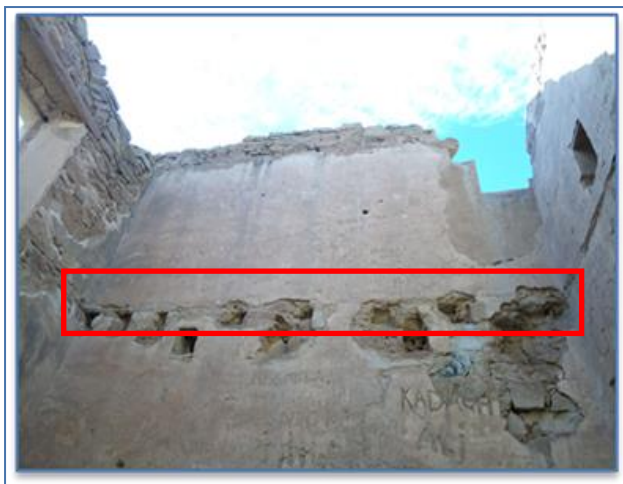
Figure 203: les planches effondrent source : Auteure
