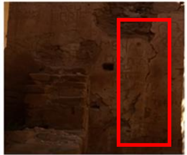
Figure 199: la fissuration des murs source : Auteure
