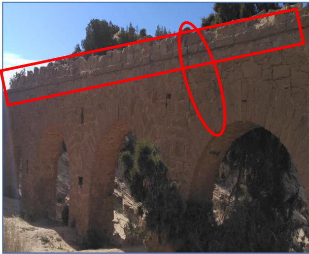
Figure 201: les fissurations au niveau les aqueducs source : Auteure
