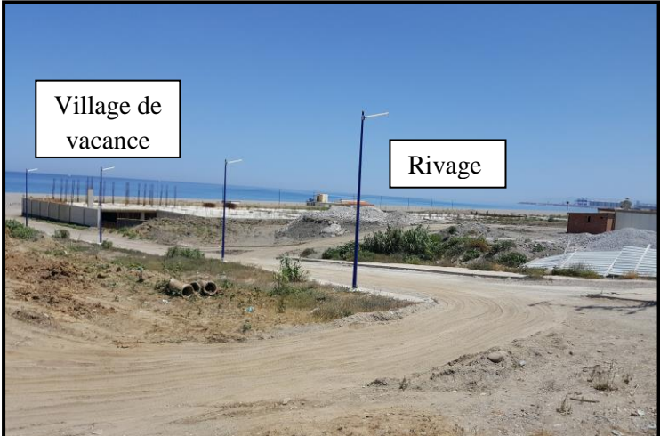
Figure 73: Nouveau village de vacance dans la ZET de Tassoust coté rivage Source : AHMIA Housseyn le 01/06/2020
