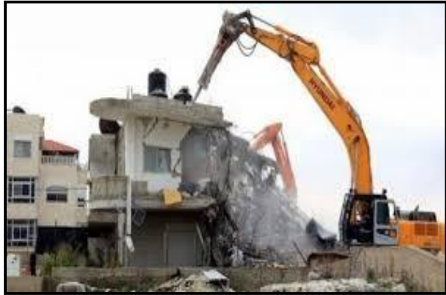
Figure 59: Démolition des constructions illicites dans la ZET de Adouane ALI
