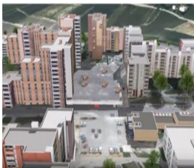
Figure 12 avant la démolition. Source : 18_AmenagementUrbainDevelopement Durable.pdf. p : 13
