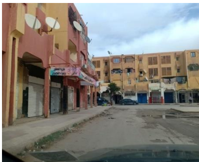
Figure 59: voie secondaire de quartier 600. source : l'auteur
