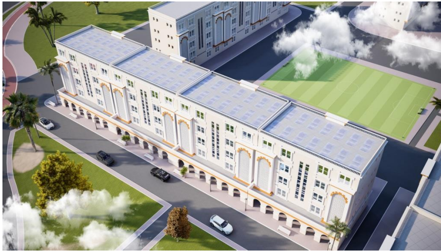
Figure 139 : panneaux photovoltaïques. Source : Auteur.
