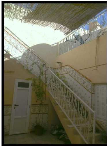
Figure 88:Vue sur la cour après l'achèvement des travaux Source : Etudiante.
