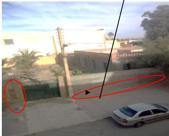
Mur de clôture (façade principale)
