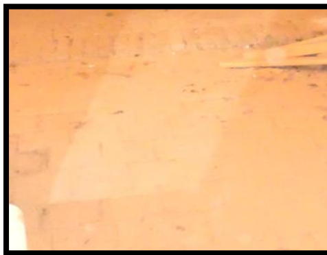
Figure 133:un ancien revêtement de sol en brique rouge. Source :BETROGTTLM
