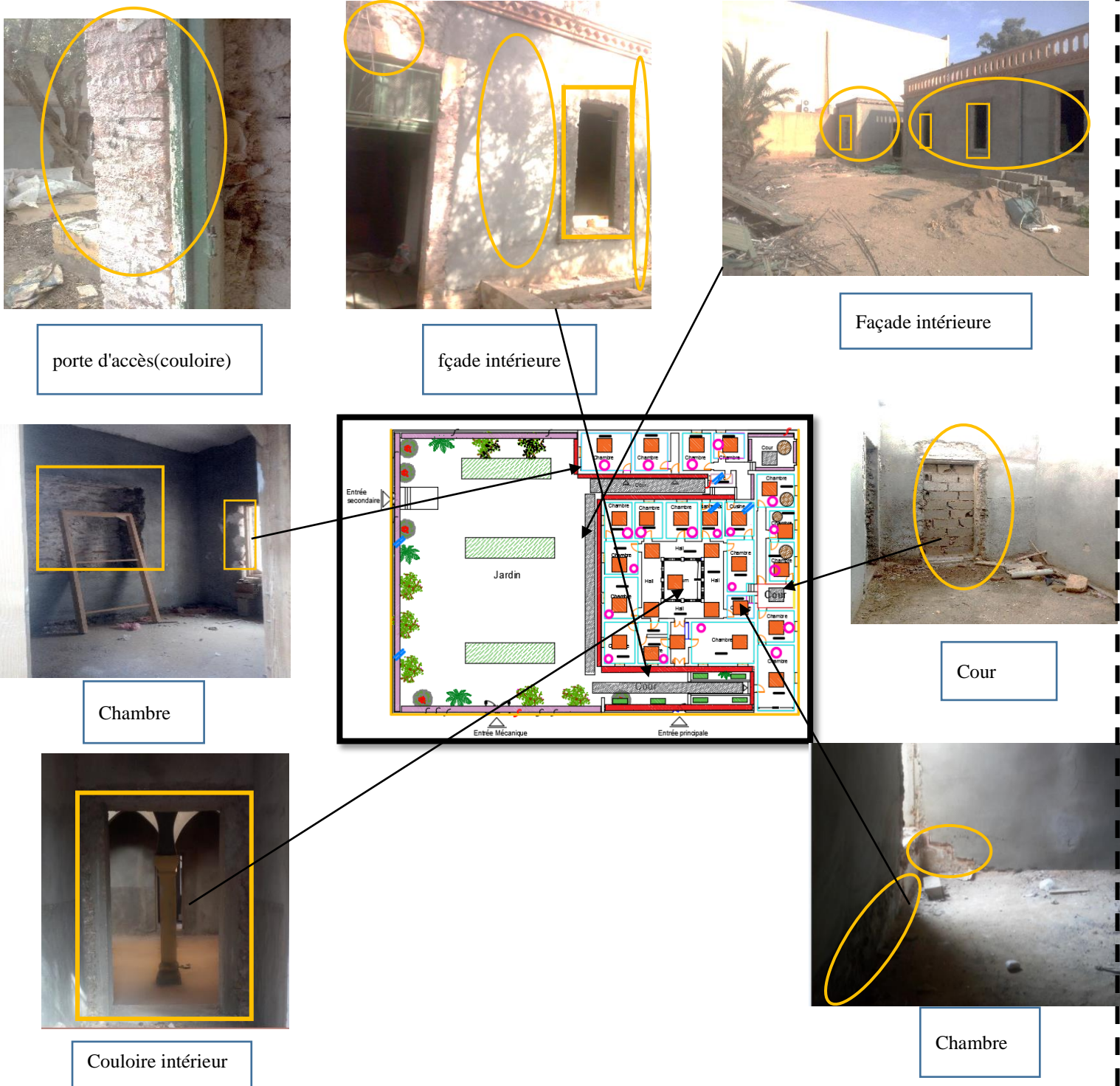
Figure 71: Enduits muraux extérieurs et intérieurs maux finis Source :Etudiantes.
