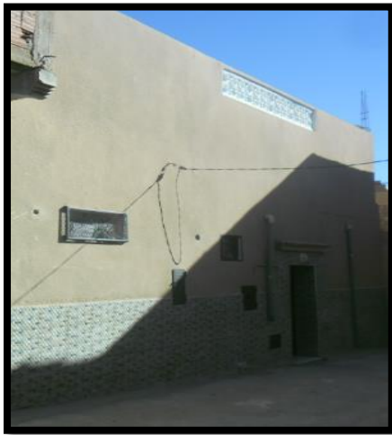
Figure 87:Vue sur la façade après l'achèvement des travaux Source : Etudiante.
