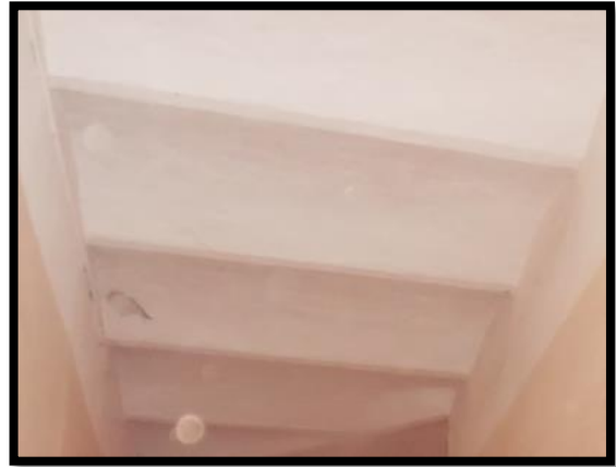
Figure 55: plancher sur voussettes Source : Etudiantes.
