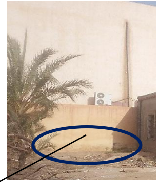
Mur de clôture (face intérieure)
