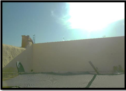
Figure 94:Vue sur la terrasse après l'achèvement des travaux Source :Etudiante.
