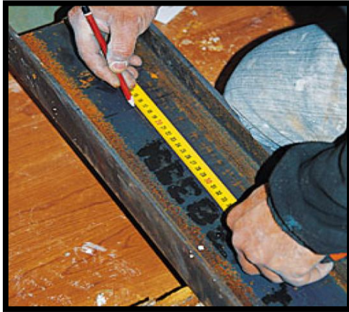
Figure 126:mésure la hauteur entre la Platine de sol et la poutre métallique Source :Ibid
