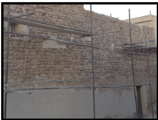
Figure 85: Décapage des mortiers endommagés Source : Etudiante.
