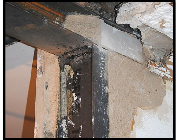
le plâtre gros pour le blocage de l'ensemble
