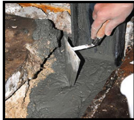
La répartition du mortier de scellement
