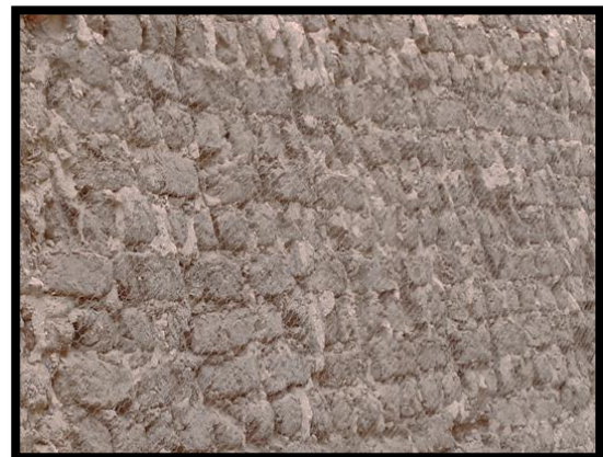
Figure 86: fixation du grillage a poule Source : Etudiante.
