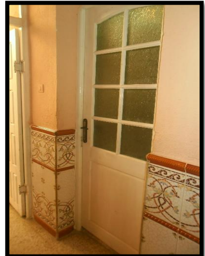
Figure 89:Vue sur l'intérieur après l'achèvement des travaux Source : Etudiante.
