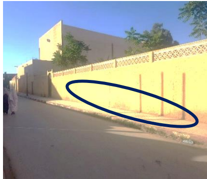
Mur de clôture (façade latérale gauche)
