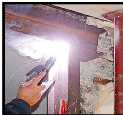
La soudure des jonctions
