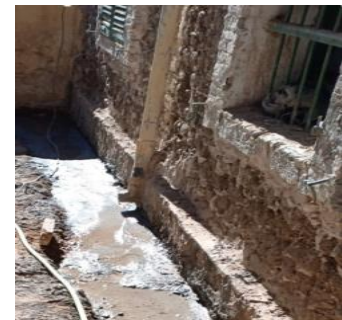
Figure 52: Mur porteur Source : bureau d'études ROGTTI .M
