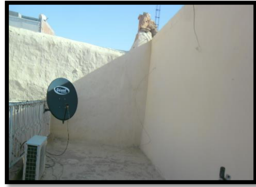
Figure 95:Vue sur la terrasse après l'achèvement des travaux Source :Etudiante.
