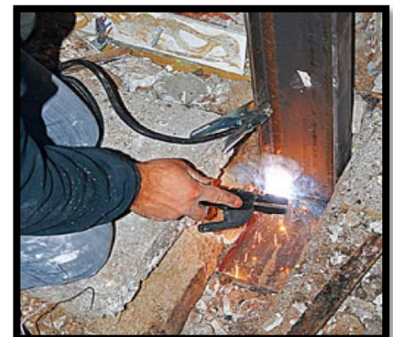
la soudure des pied des poteaux métalliques.
