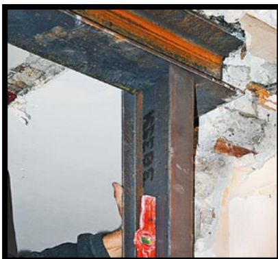
Fixation des poteaux .M
