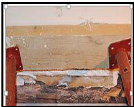
Poutre en bois.
