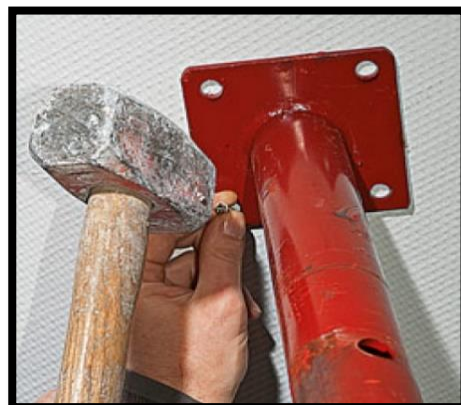
Fixation des étais à l'aide des cloues
