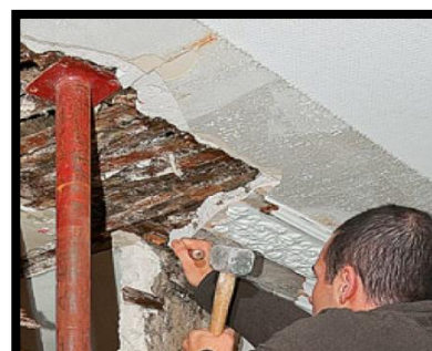
Figure 122:Démolition du mur Source :Ibid
