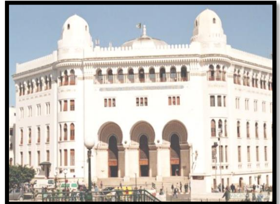
Figure 4: Grande poste d'Alger Source : www.google.com .
