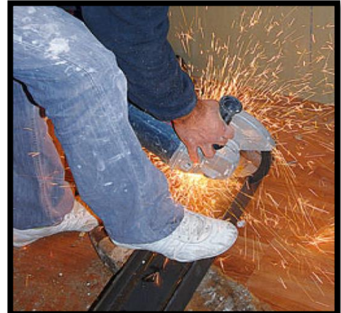
Figure 127:la découpe des poteaux à la bonne dimension Source :Ibid
