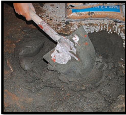
Gâchage du mortier de scellement
