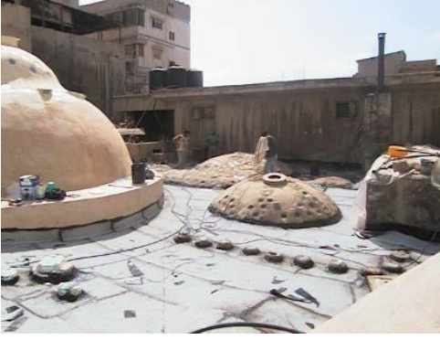
الشكل(97): وحدات الإضاءة المستعملة داخل الحمام.
