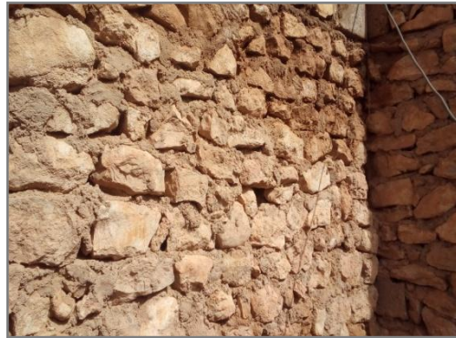
الشكل 116: جدران مبنية بالحجارة
