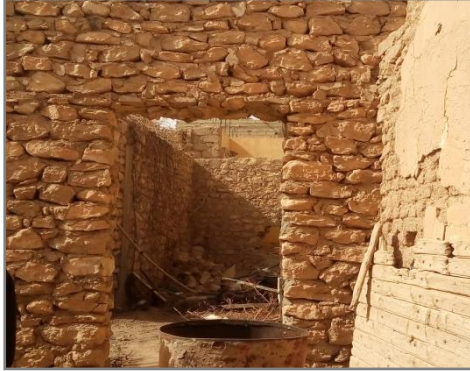
الشكل 116: جدران مبنية بالحجارة
