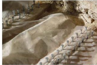
الشكل (192): إضافة عدد إضافي من بلاطات الخرسانة المسلحة
