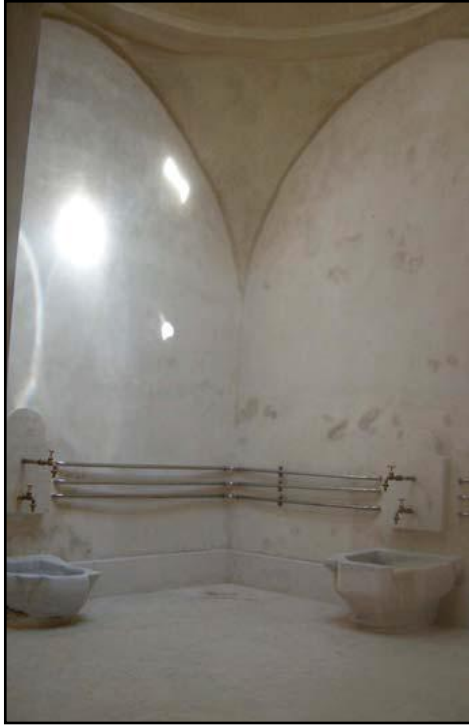
الشكل (179): تركيب أنابيب الماء في الحمامات العثمانية العمرية.
