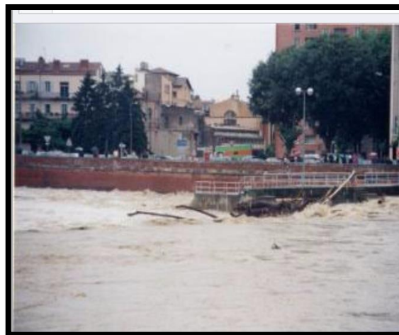
Figure 5:l'inondation de TOULOUSE 2000. Source : www.toulouse-inondation.org
