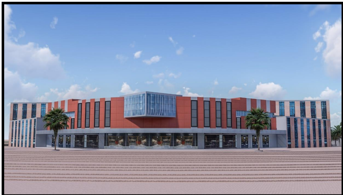
Figure 64: souk ouvert et la centre commercial. source : traité par l'auteur .
