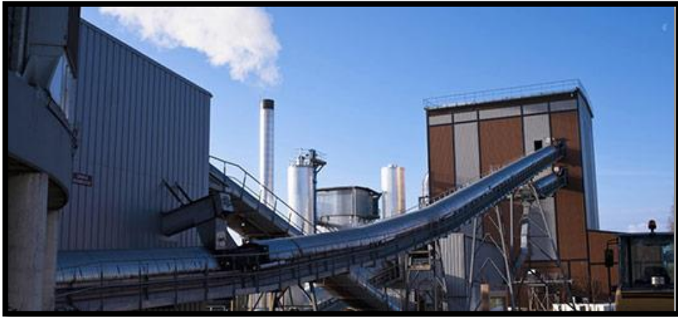
Figure 85 : usine pour l'énergie de la biomasse
