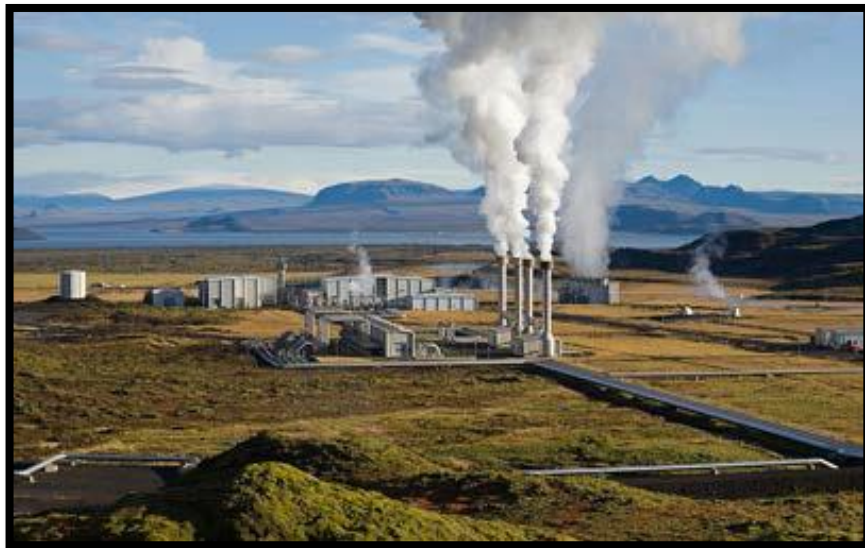
Figure 86 : Centre de l'énergie géothermique
