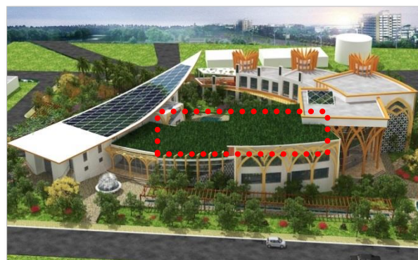
Fig. IV.37: toiture végétalisée Source : les auteurs
