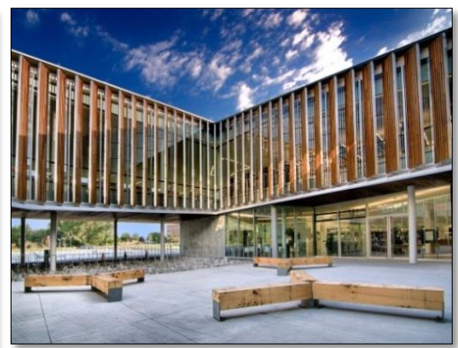
Fig. I.17 : Les brise-soleil actifs Source :www.voirvert.ca
