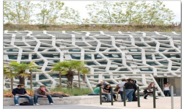
Fig. I.30 : l'intégration de la bibliothèque Florence-Delay dans son environnement Source : http://www.pss-archi.eu/immeubles
