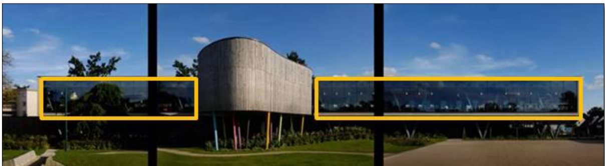
FigIII.15: la façade Nord de médiathèque René Goscinny Source:Médiathèque. ludothèque. espace jeunesse
