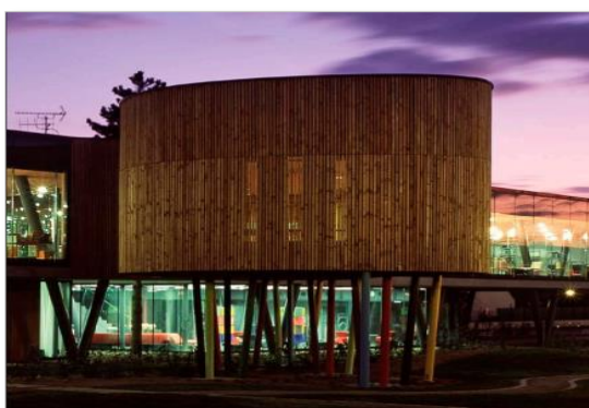
FigIII.18: Revêtement extérieur en bois Source: Forma6 Médiathèque - Ludothèque
