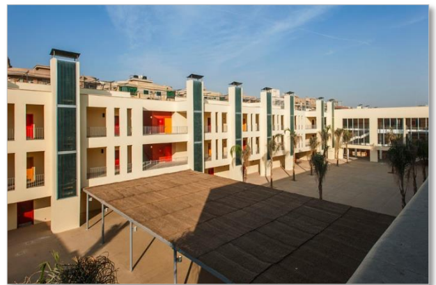
FigIII.10: la cheminée solaire Source : www.derbesse-delmanque-architects.com
