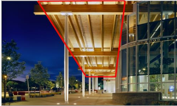
Fig. I.45: l'avancement de toiture source: https://www.pinterest.com/Auteurs
