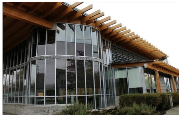
Fig. I.44: mur rideau avec film photovoltaïque Source: https://www.pinterest.com
