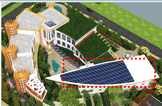
Fig. IV.38: Vue sur les panneaux photovoltaïques de la salle de conférence Source : les auteurs
