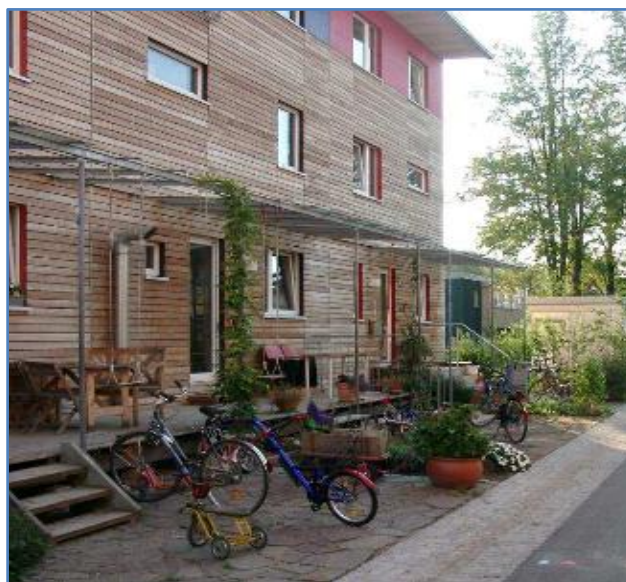
Figure 49 :Bâti en bois – quartier Vauban Fribourg Source : (Quartier Vauban Compte-rendu, visite du Service du logement & des gérances - UL, 06-10-2006).
