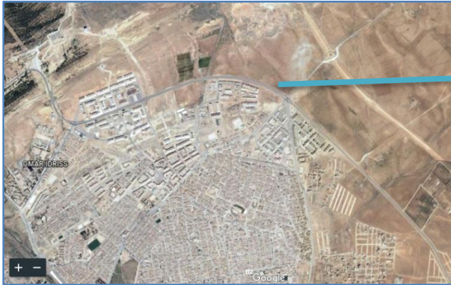
Figure 67 : Photo aérienne sur le site d'intervention. Source : (Google earth ).
