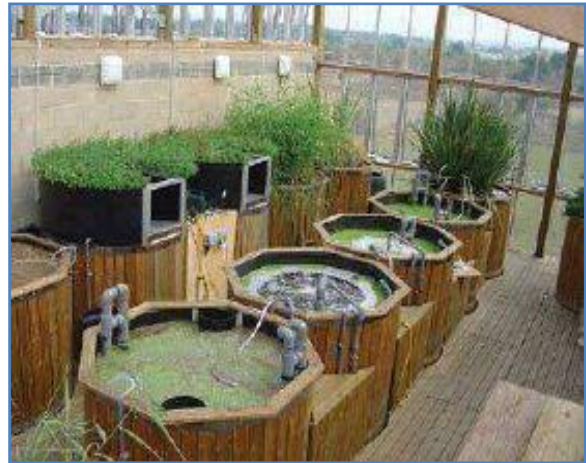
Figure 34 : Traitement de l'eau.
