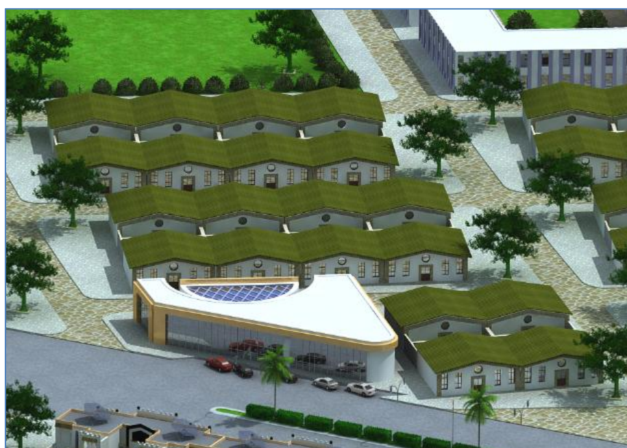
Figure 93 : L'utilisation de toitures végétales. Source : Les auteurs.
