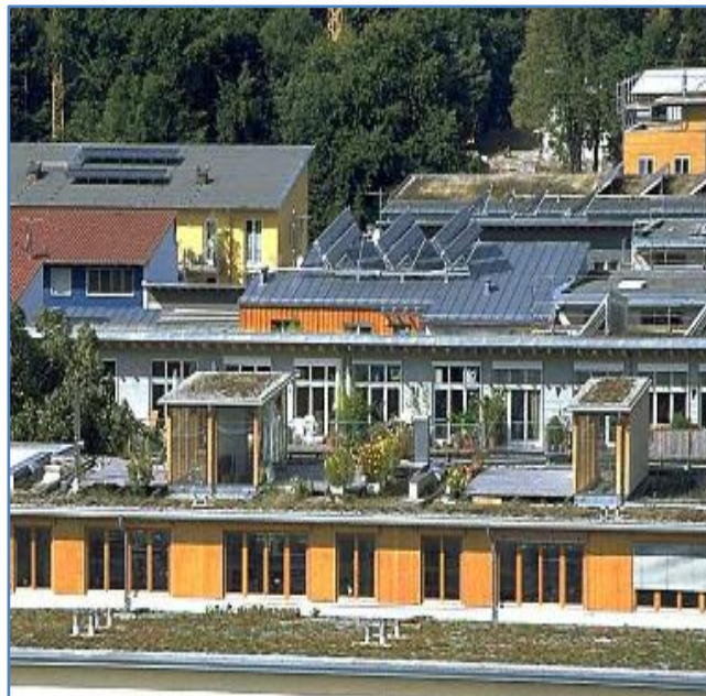
Figure 46 : Toiture avec panneaux photovoltaïques quartier Vauban Fribourg.
