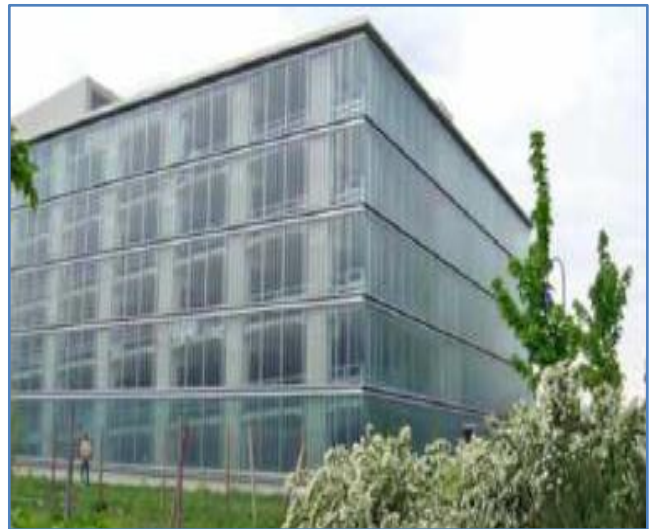
Figure 50: Parkings a niveaux de quartier Vauban Fribourg . Source : ( Quartier Vauban Compte-rendu, visite du Service du logement & des gérances - UL, 06-10-2006 ).
