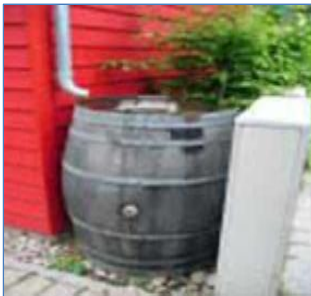
Figure 47 : Système de récupération des eaux pluviales.
