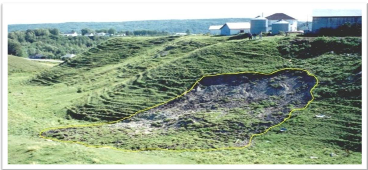
Figure I.13 : Exemple de glissement superficiel [15].
