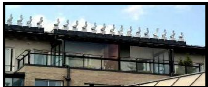
Figure 30 : l'échangeur d'air, Source : www.helsinginenergia.fi/kaukolampo/ekoviikki.html
