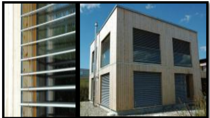
Figure 59 : store électrique utilise dans la maison, Source : http://lab-immo.ch/1037/-/ Minergie-P-ECO MAISON
