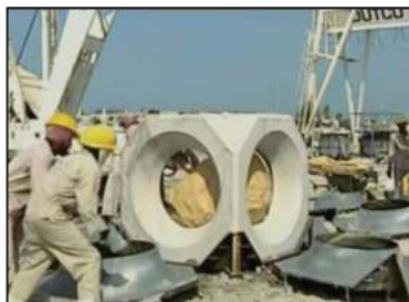
L'utilisation des blocs de béton
