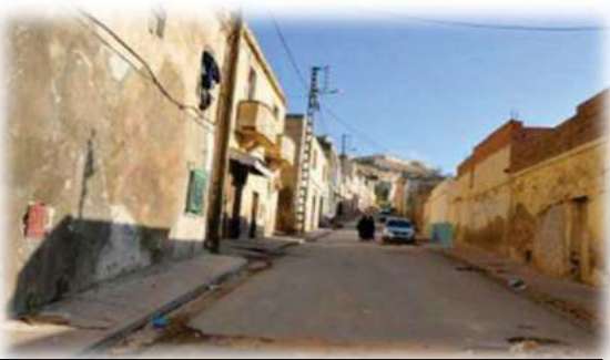
Photo 55: état dégradé d'habitat Source : étudiantes
