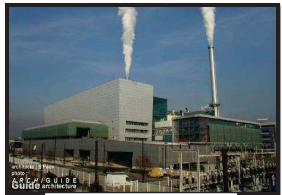
Photo : l'incinération Source : Google image
