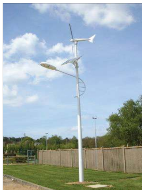
Photo 86: poteau d'éclairage autonome Source : Google image
