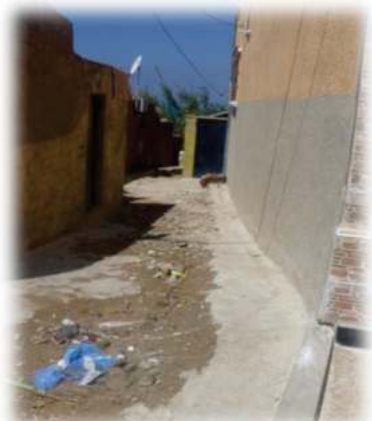
Photo 53: étroitesse des voies Source : étudiantes
