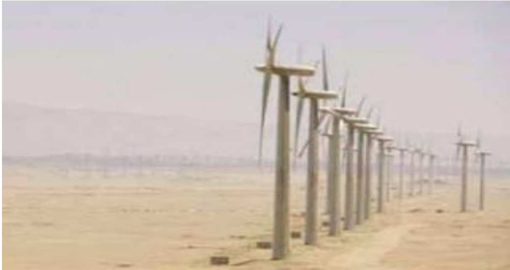
Figure I.15 Le parc éolien de Kabertène.
