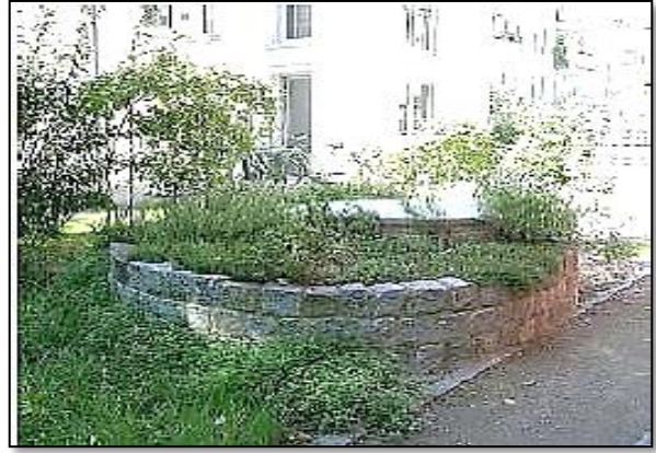
الشكل I. 31: أحواض تجمع مياه الأمطار المصدر: www.ellenmacarthurfoundation.org
