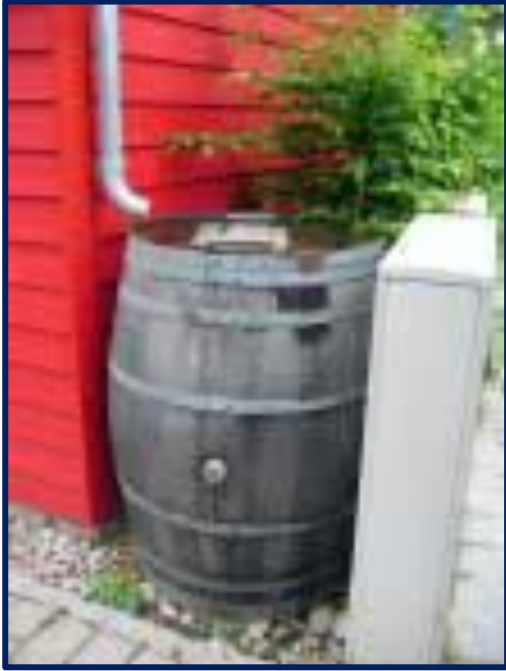
صورة 20: صورة توضح خزانات استرجاع مياه الامطار
