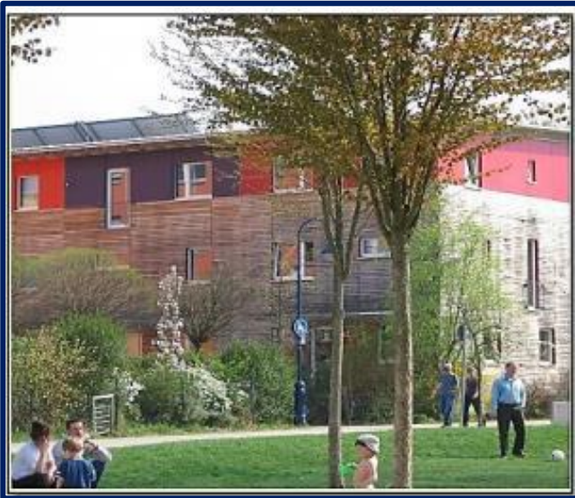
صورة 21: بعض مواد البناء المستخدمة
