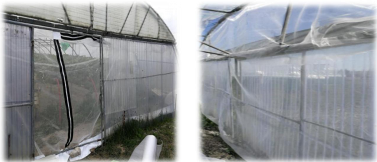
Figure10 : Mise en place du filet des 2 côtés de la serre sur l'exploitation (Pham et al ,2015).
