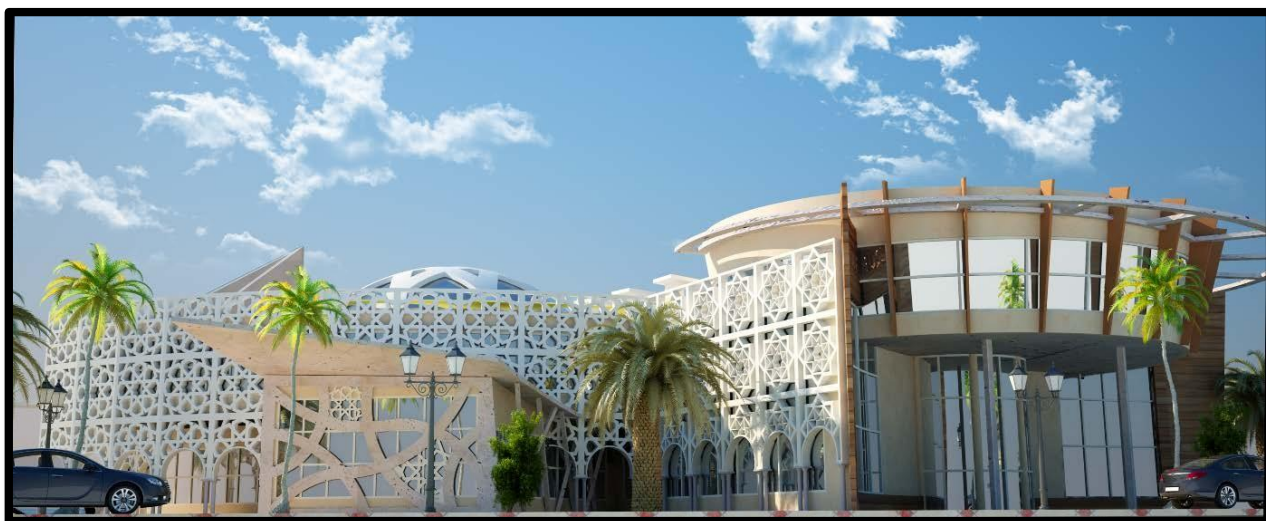
Figure 103 : Vue sur la façade Est. Source : Auteurs.
