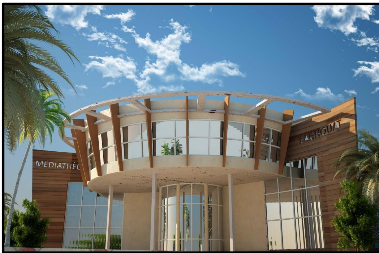
Annexe 5 : Vue sur l'entrée principale
