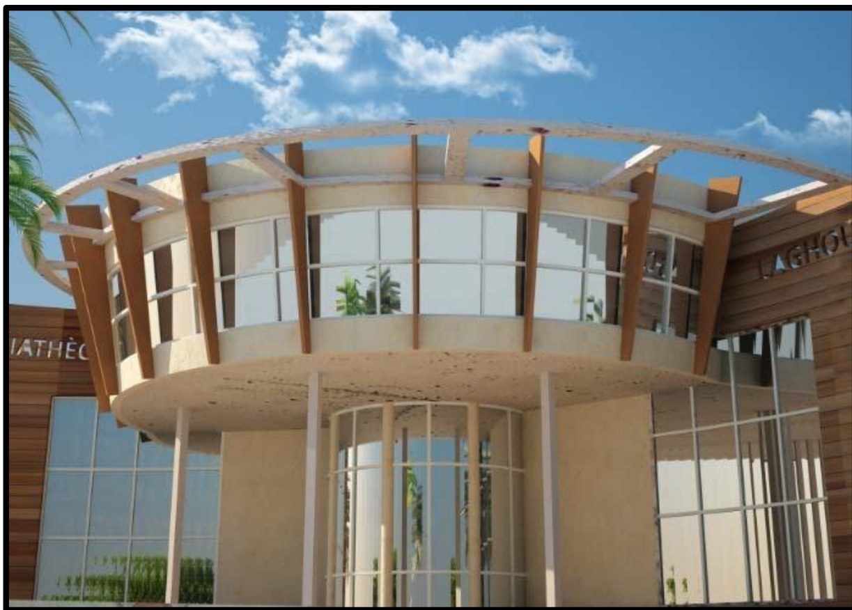
Figure 97 : Vue sur le vitrage bombé. Source : Auteurs.
