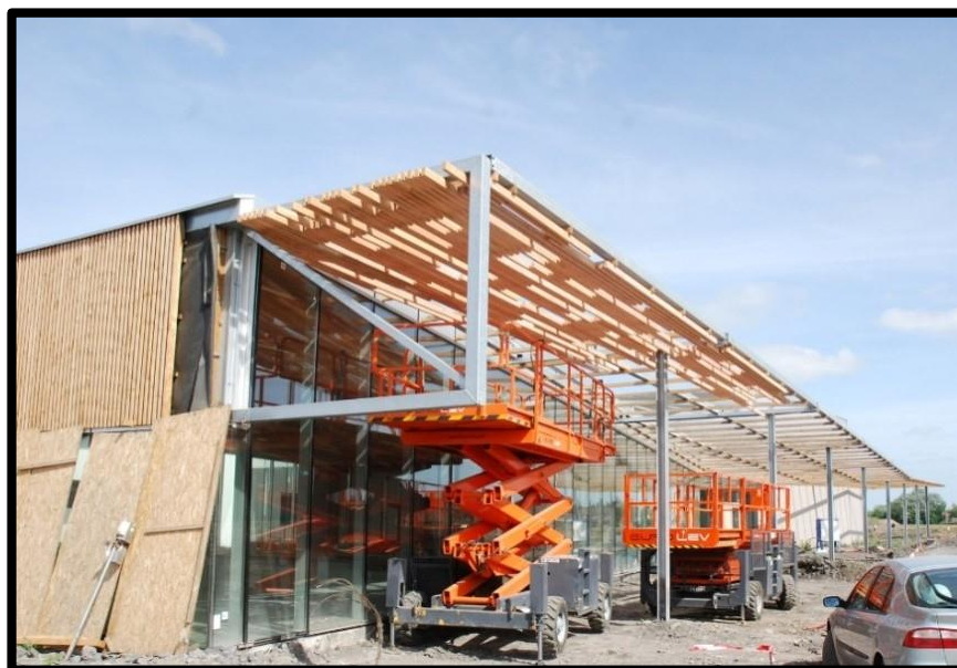
Figure 24 : L'auvent de la médiathèque. Source : actuarchi.com.
