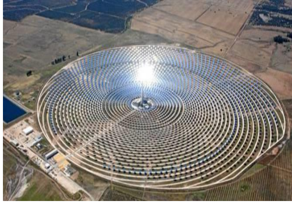
Figure IV. 6 Centrale thermodynamique à Dubaï. Source: https://blogs.mediapart.fr/enerconfort/blog/090616/dubai-et-son-projet-de-la-plus-grande-centrale-solaire-au-monde
