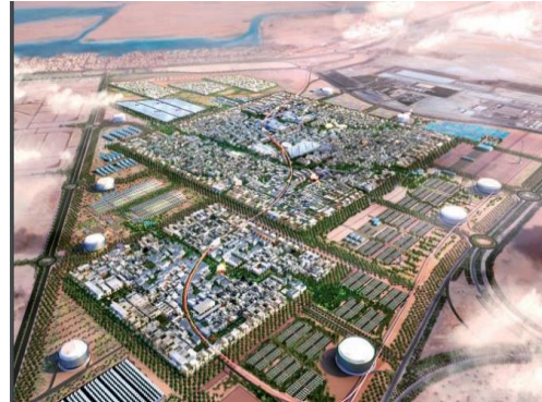
Figure I. 57 la ville de Masdar. Source : http://www.architecture-studio.fr
