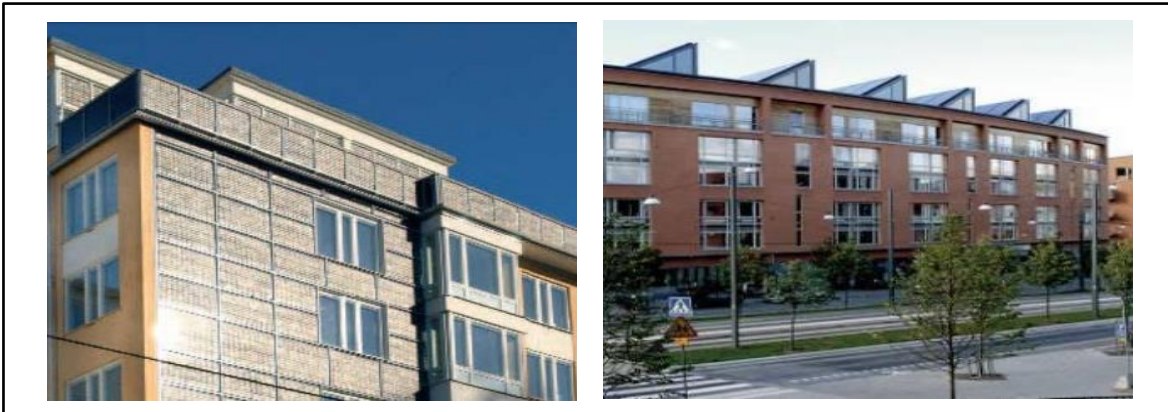
Figure I. 28 la disposition de panneaux solaires sur la façade. Source : http://web.worldbank.org/
