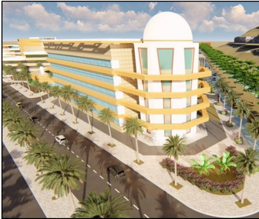
Figure III. 14 Vue sur l'hôtel Source : auteurs
