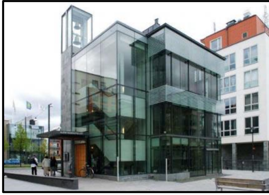
Figure I. 17 Centre d'information environnemental Source: http://www.solaripedia.com/pdf
