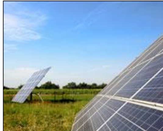
Figure IV. 12 panneaux solaires sur suiveur solaire. Source: https://solabel.be/photovoltaique/
