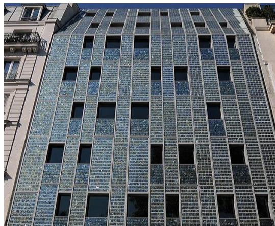
Figure IV. 9 façade composé entièrement de panneaux solaire à Paris, France Source : https://www.18h39.fr/articles/la-premiere-facade-entierement-recouverte-de-panneaux-solaires.html
