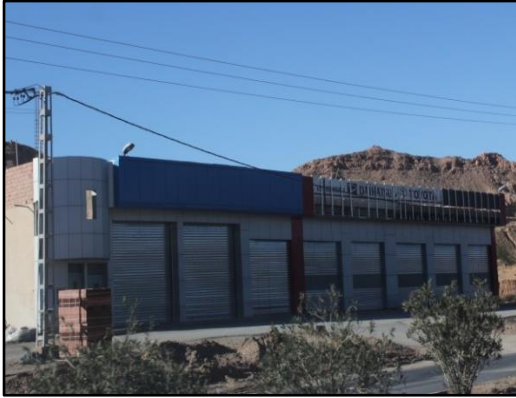
Figure II. 28 Station technique SNC Ben moussa Source: Prise par les auteurs
