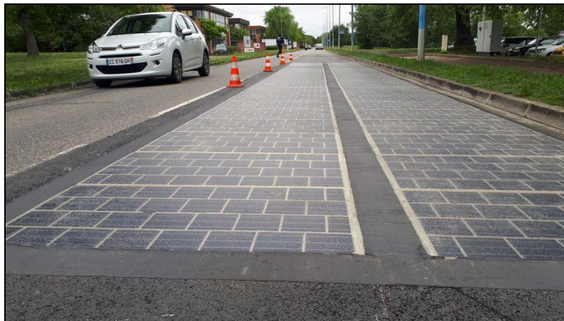
Figure IV. 17 Routes solaires. Source : https://www.francebleu.fr/infos/climat-environnement
