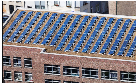
Figure IV. 8 installation des panneaux solaires sur le toit de bâtiment résidentiel. Source : https://fr.depositphotos.com/
