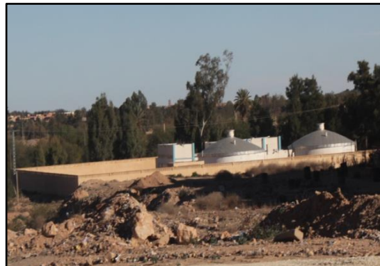
Figure II. 30 Réservoir d'eau Source: Prise par les auteurs
