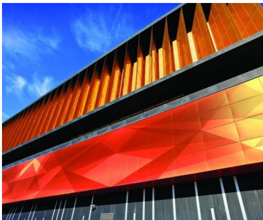
Figure IV. 10 Des panneaux solaires orangés intégrés à une façade Source : https://www.sciencesetavenir.fr/nature-environnement/
