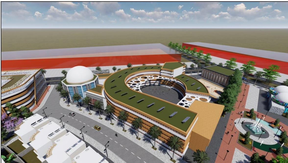
Figure III. 52 Installation des panneaux photovoltaïques au niveau des équipements. Source : auteurs
