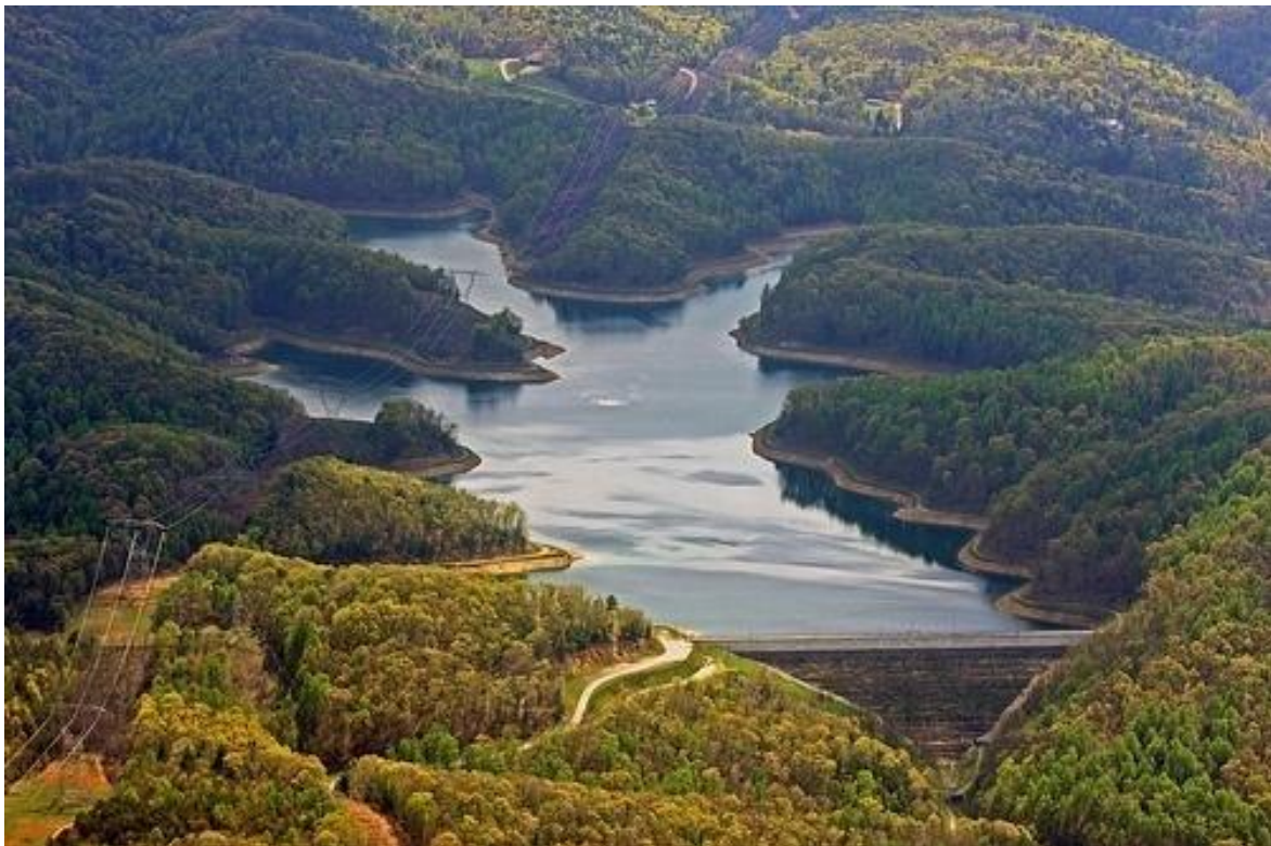
Figure 24: Spring Hollow Reservoir (Prise le 24 avril 2008 par Western Virginia Water Authority )
