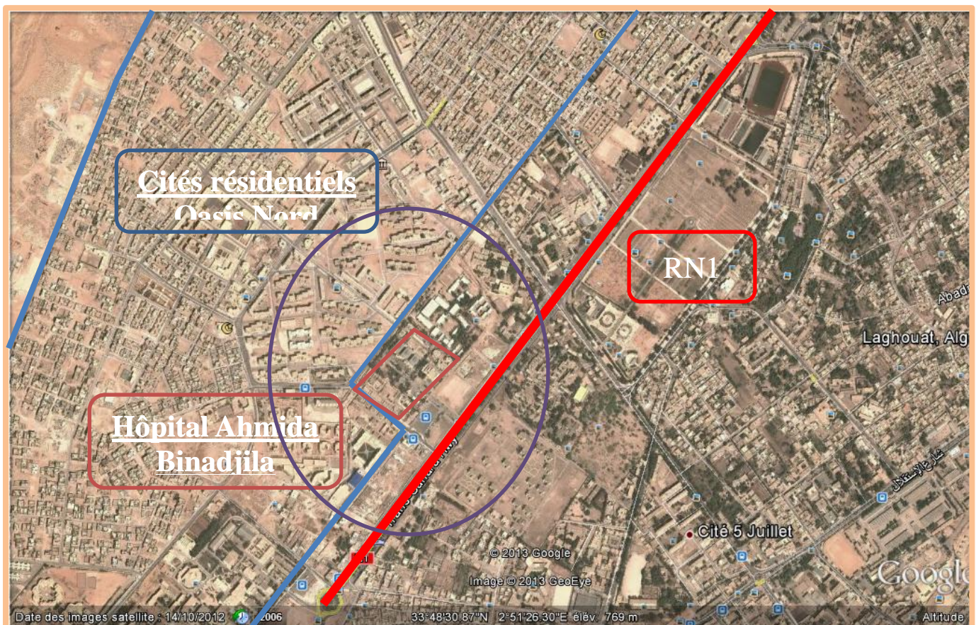
Fig.III-13 : Photo satellitaire sur le site recevant le projet. Source : Google Earth 2013.
