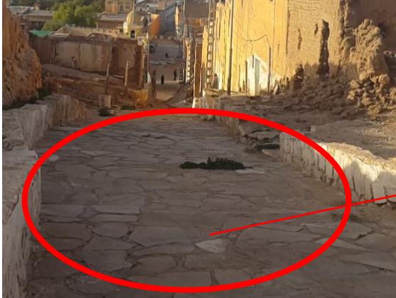
Fig III 146 l'utilisation de la pierre plate dans le ZGZG ELHADJAJ
