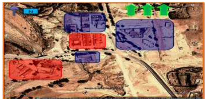
Figure N 49 : Présentation des anciens et nouveaux bâtiments, Source :ONMD Djelfa
