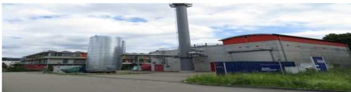
Figure 35:Une centrale de cogénération du quartier Vauban
