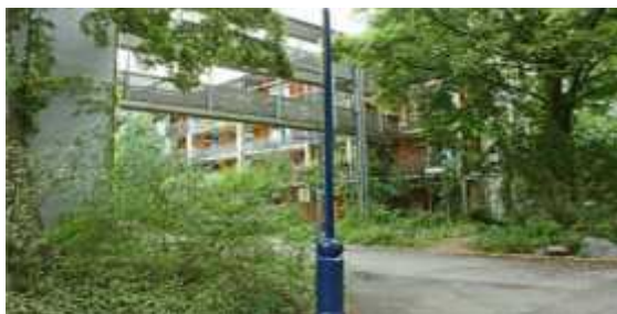
Figure N 32: Un des immeubles de la société coopérative [ www.genova-vauban.de ]
