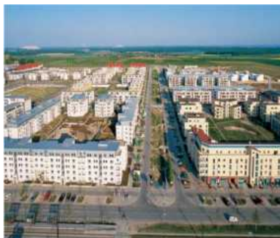
Figure N 11 : La résidence de Kronsberg Source : www.stuttgart.de/umwelt
