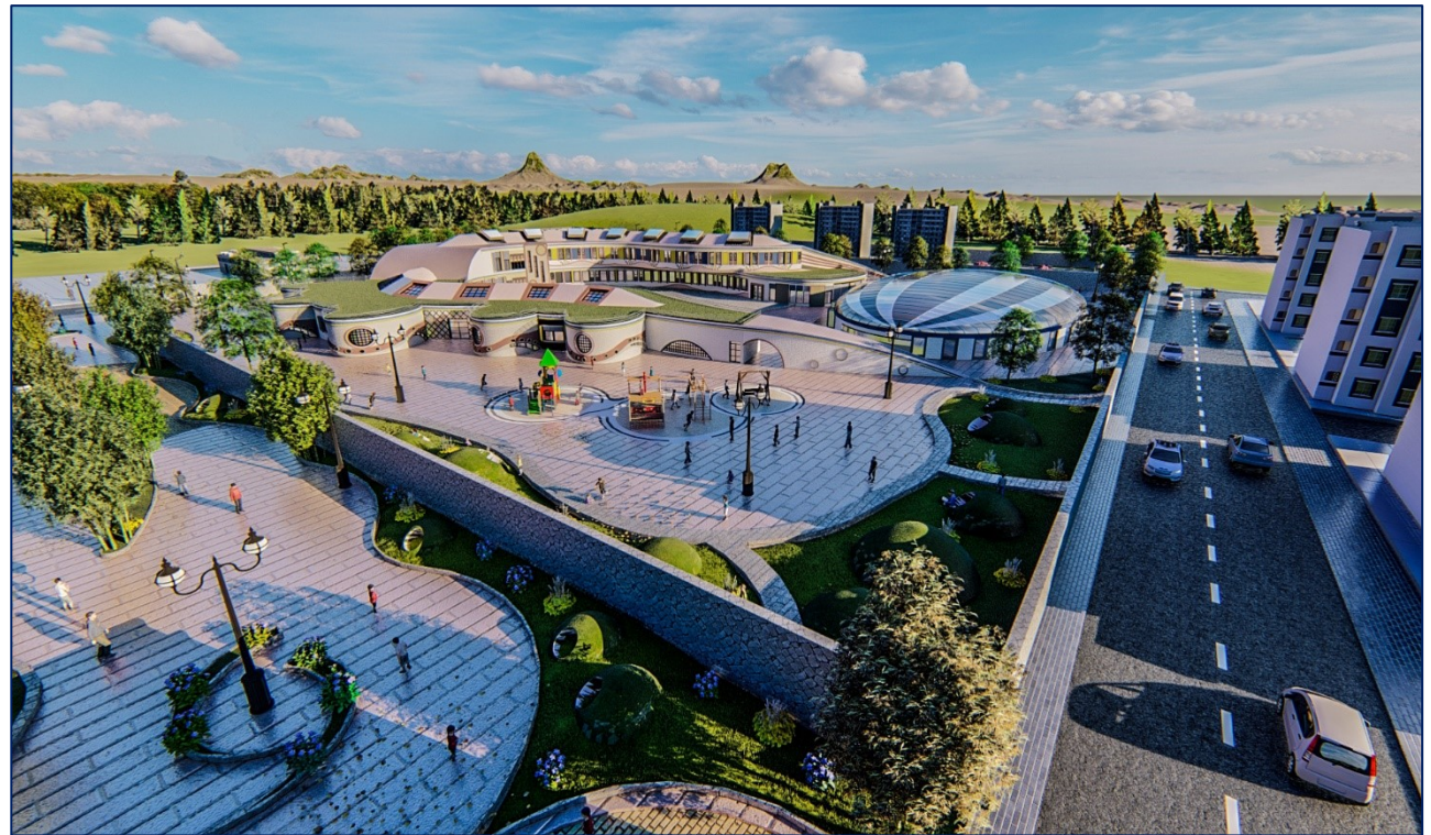
Figure 249: vue extérieure de projet
