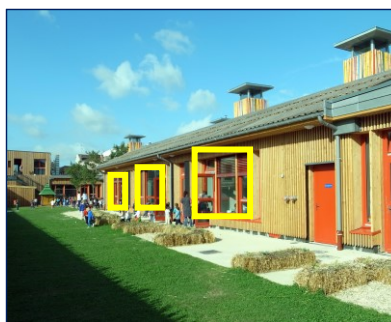
Figure 46: façade de l'école maternelle. Source : batirama.com
