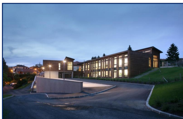
Figure 76: Façade nord-ouest. Source : Reportage_chantier_montrottier_VAD.pdf
