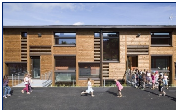
Figure 75: Façade Sud- EST Ecole élémentaire. Source : Reportage_chantier_montrottier_VAD.pdf
