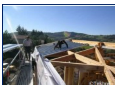
Figure 79: bac acier (la toiture). Source : Reportage_chantier_montrottier_VAD.pdf
