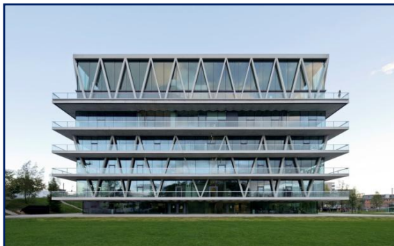
Figure 13: façade de Christian Kerez : école Leutschenbach, Zurich, zone communautaire à l'étage. Source : ( http://www.archdaily.com )
