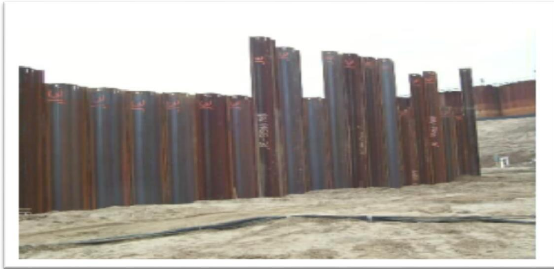
Fig.I.9 Assemblage des éléments des palplanches.
