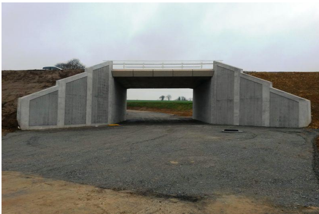
B5 : Image représentative d'un pont portique.
