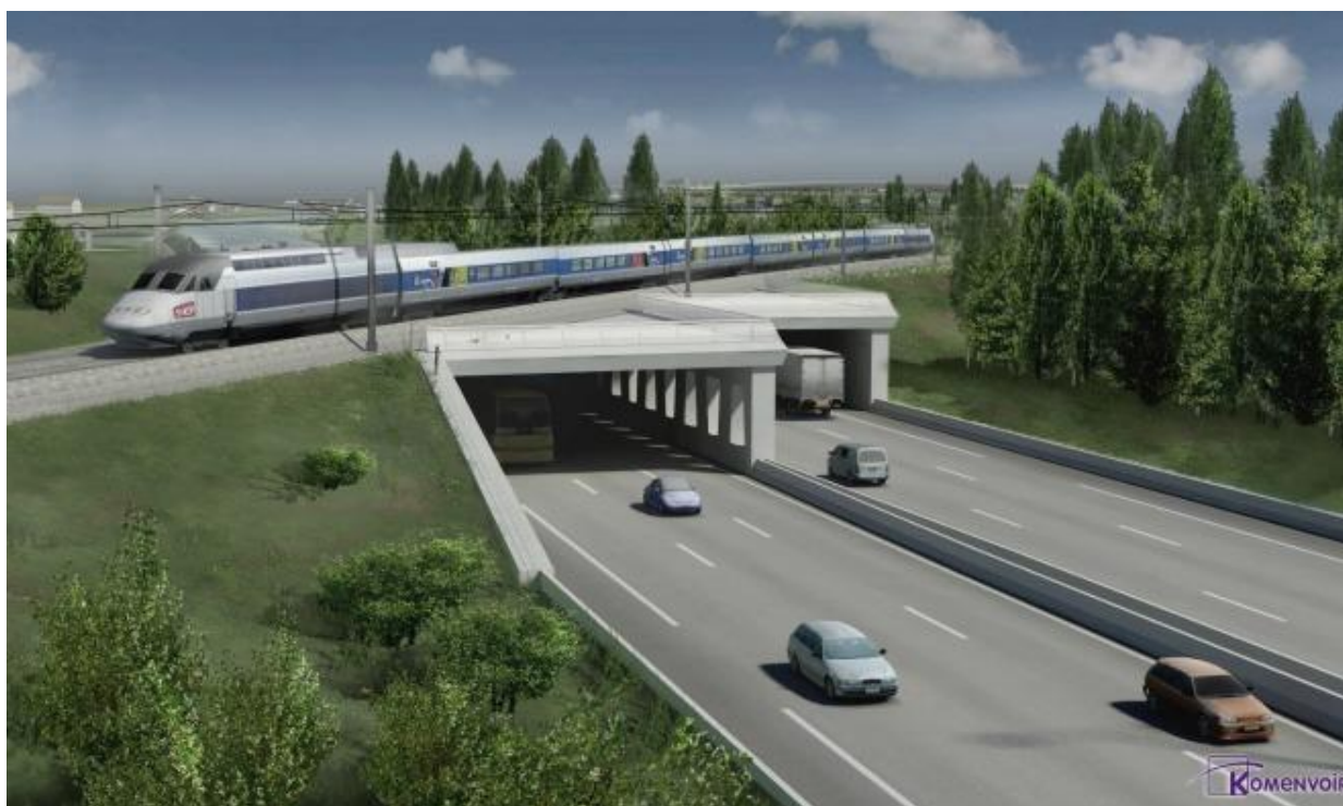
A15 : Passage supérieur de la voie ferrée sur un pont rail franchissant l'autoroute.
