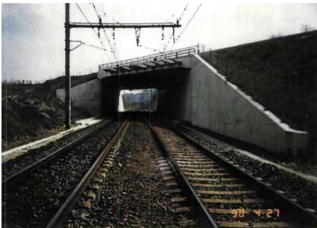
B6 : Image représentative d'un passage inférieur de la voie ferrée sous pont portique.
