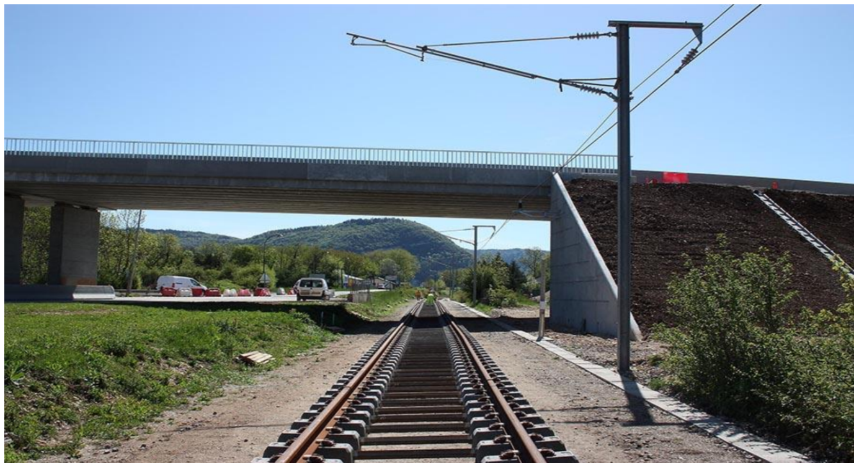
A14 : Passage supérieur de la route sur un pont route franchissant la voie ferrée.
