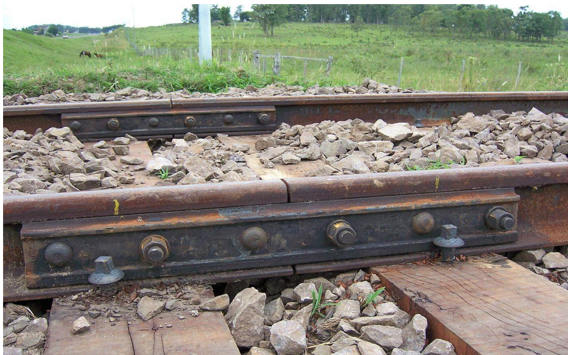
Fig. IV.23 : Exemple d'un joint de dilatation éclissé.
