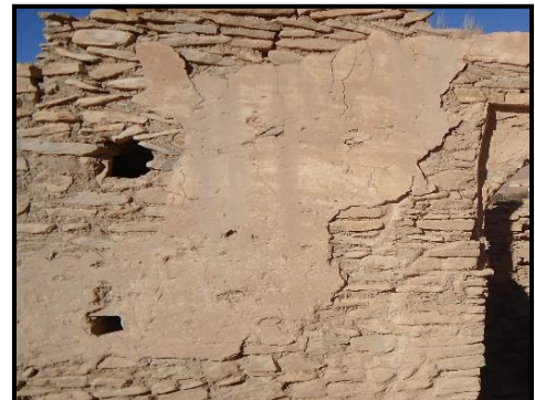
Fig. 99 : Mur en pierre enduit. Ksar Taouiala.
