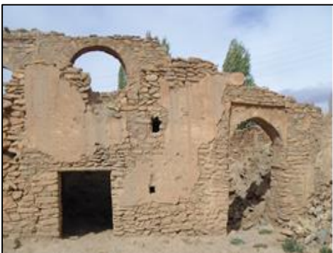
Fig. 85 : Arc Plein cintre.
