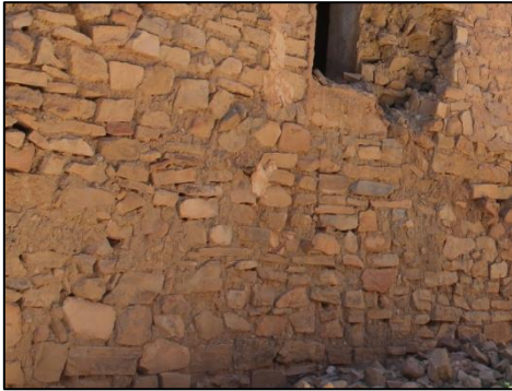
Fig. 96 : Mur illustrant son hétérogénéité. Ksar Taouiala.
