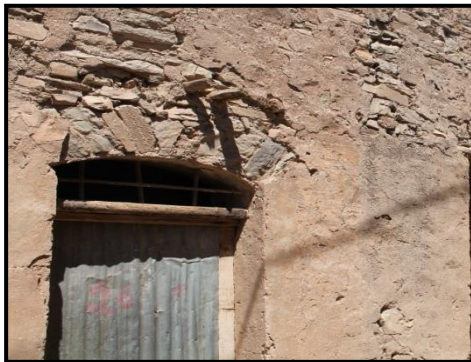
Fig. 98 : Mur en pierre enduit. Ksar Taouiala.
