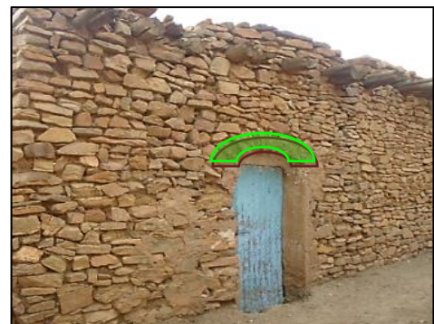
Fig. 80 : Les portes à ksar taouiala.
