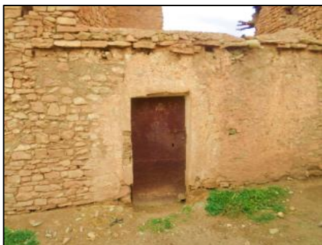
Fig. 79 : Les portes à ksar taouiala.
