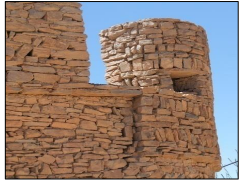
Fig. 46 : La Tour du coté sud-est du Ksar.
