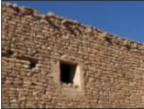
Fig. 81 : Les fenêtres à ksar taouiala.
