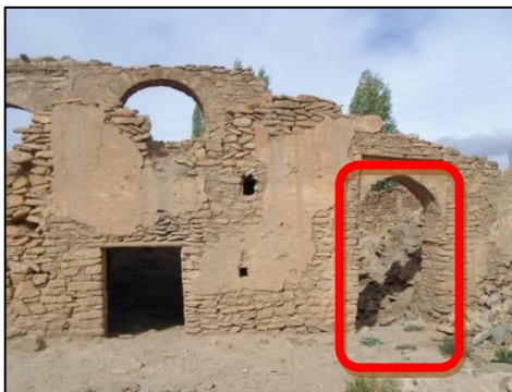
Fig. 47 : Entré Palais de l'Agha Dine du Ksar.
