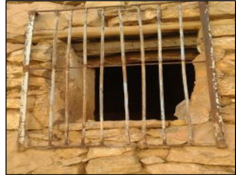
Fig. 82 : Les fenêtres à ksar taouiala.
