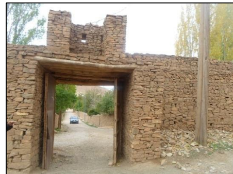
Fig. 44 : La porte nord vers l'extérieur du Ksar.
