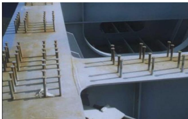
Fig VI-9 : connecteurs de type goujons
