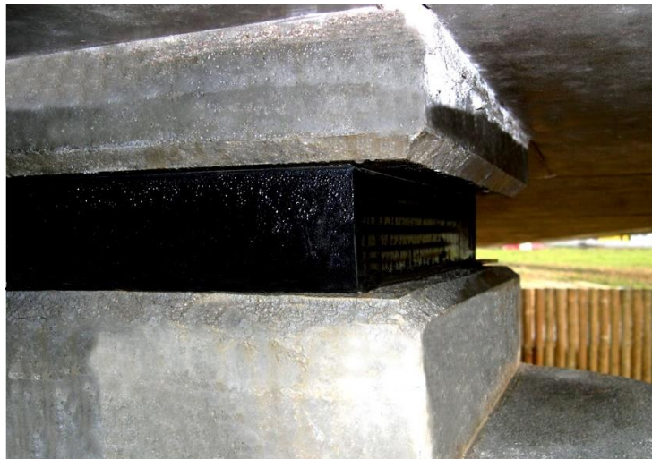
Photo VII-1 : Photo réelle d'un appareil d'appuis en élastomère fretté
