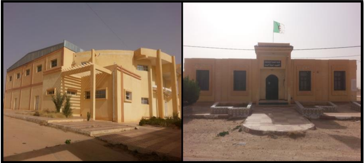
الشكل 62: صور توضح المنشآت الموجودة في الحي
