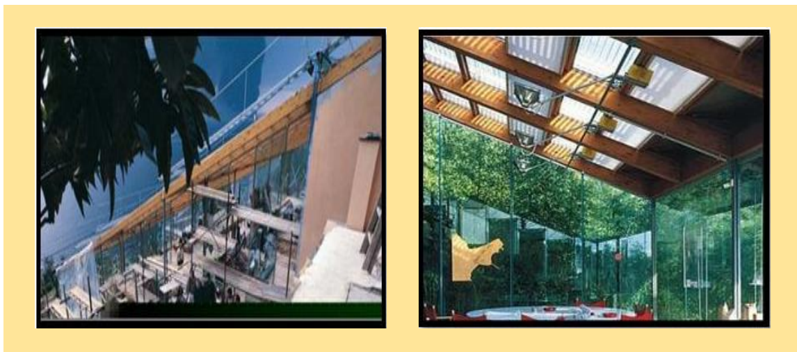
Figure II. 9 : Toiture du projet. Source : Fondazione renzopiano.org.
