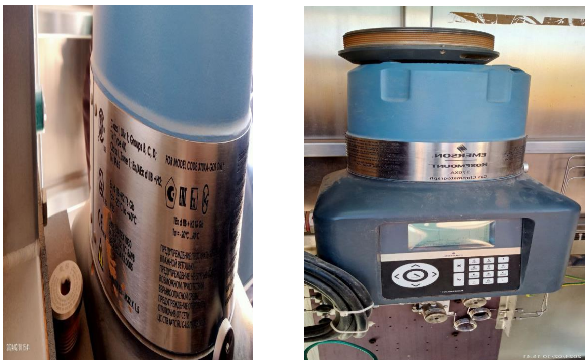
Figure 22: Chromatographe 14-AE-497 "Analyseur du gaz"
