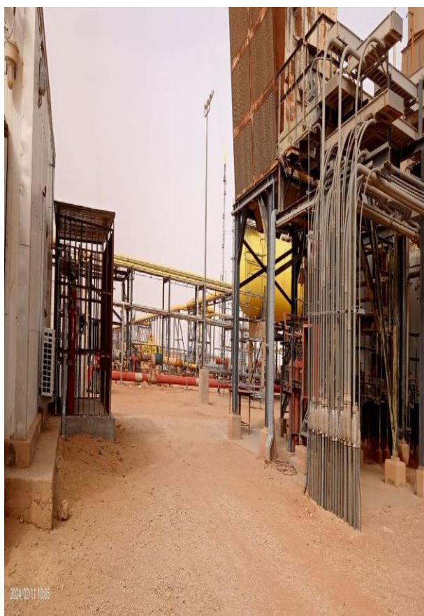
Figure 28: L'existence des climatiseurs non-ATEX dans une zone ATEX
