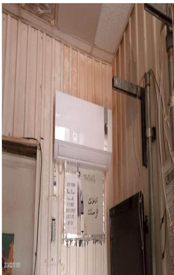
Figure 28: L'existence des climatiseurs non-ATEX dans une zone ATEX
