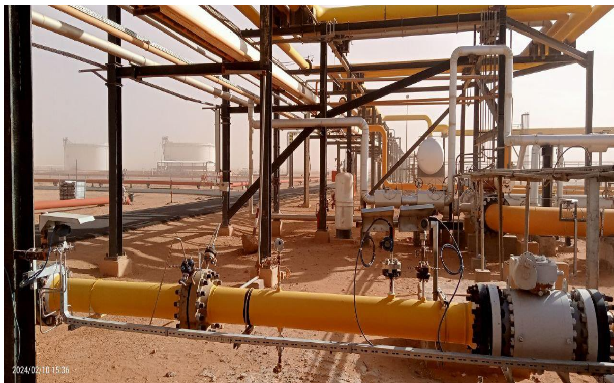
Figure 27: Aucune signalisation de limites des zones ATEX
