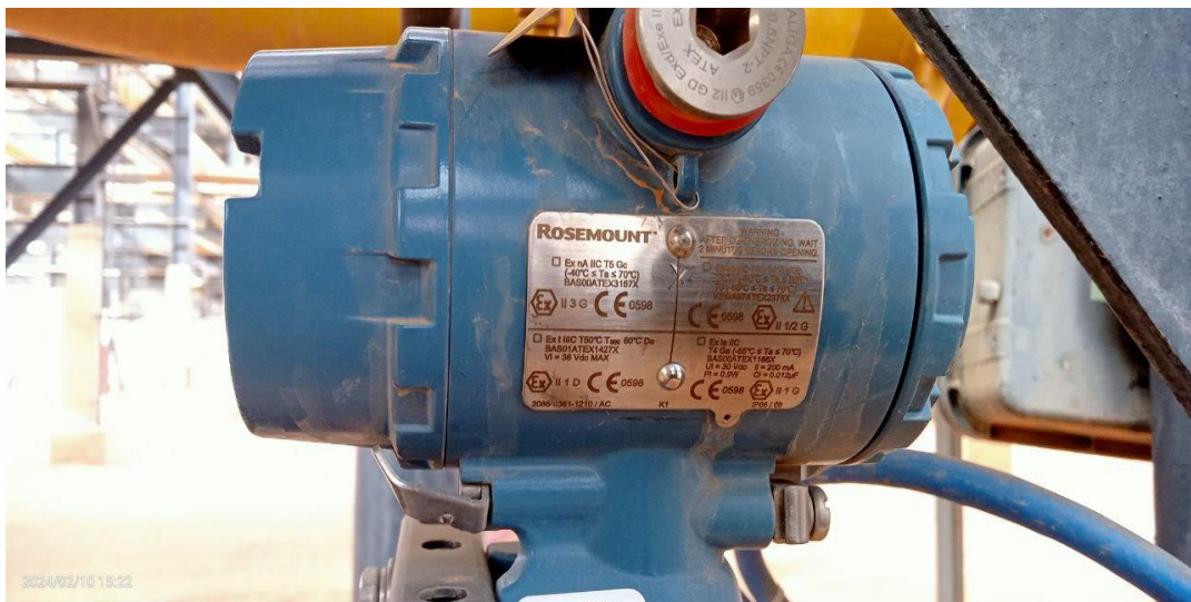
Figure 21: Transmetteur de pression PT455 -ATEX-
