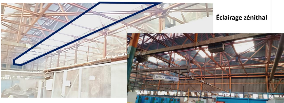
Figure II-21: « éclairage zénithal des ateliers soudage, photos prise et traité par l'auteur
