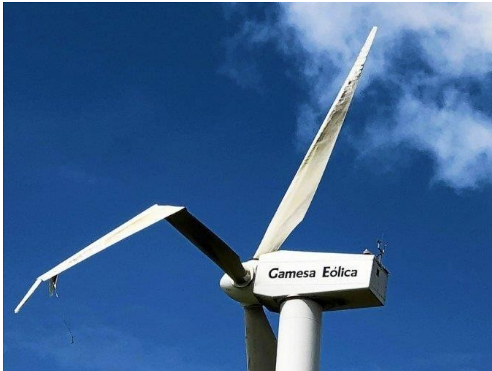
Figure 2.3: Une pale sévèrement endommagée au parc éolien à Plouarzel
