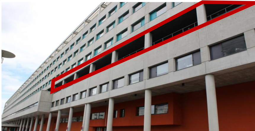
Figure 42 : Façade latérale Source : www.ecmat.fr
