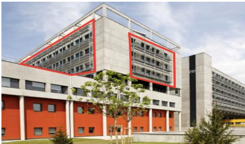
Figure 43 Façade latérale Source : www.ecmat.fr
