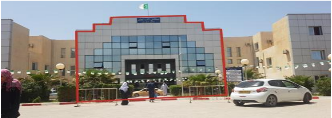
Figure61 : Façade de l'entrie principale Source : auteur
