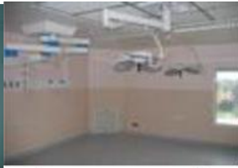
Figure 46 : Bloc opératoire maternité Source : www.Promenade.temporelle.fr
