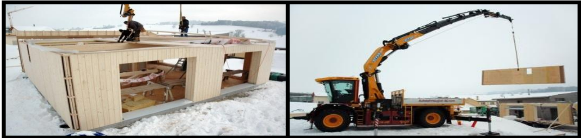
Figure 41 : photos qui montre les travaux de réalisation, Source : http://lab-immo.ch/1037-/ Minergie-P-ECO MAISON
