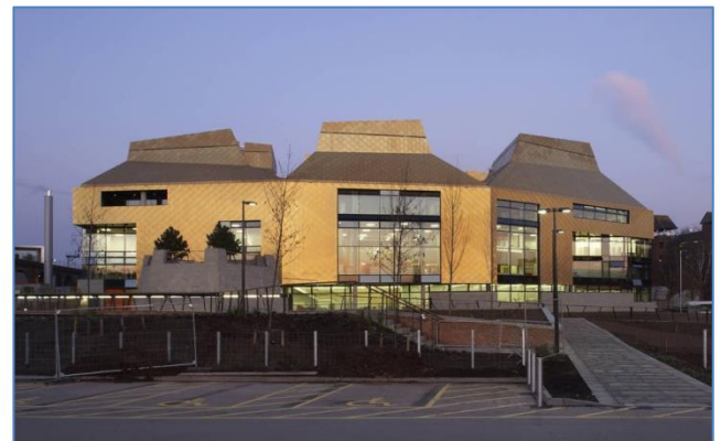
Figure73: façade ouest de bibliothèque the HIV (Source : www.thehiveworcester.org )
