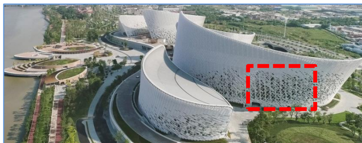
Figure38: façade sud-ouest de centre de FUZHOU (Source : https://static.dezeen.com )
