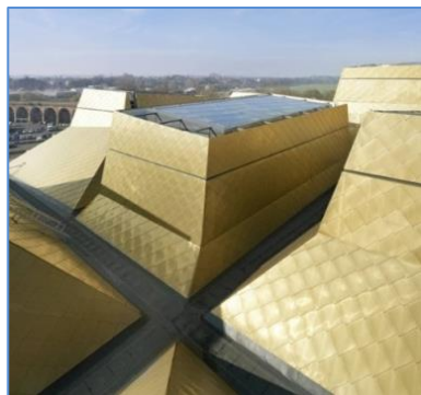
Figure76: vue extérieure des cônes de bibliothèque the HIV (Source : beautifullibraries.wordpress.com )
