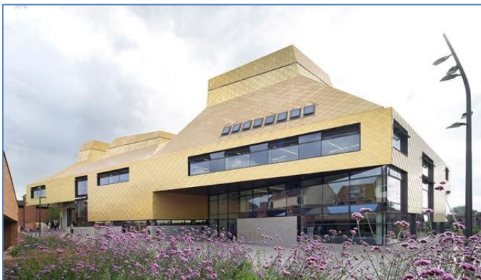
Figure72: façade nord-est de bibliothèque the HIV (Source : www.thehiveworcester.org )
