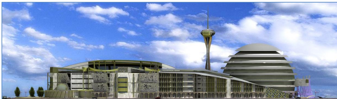
Figure 27:La Façade nord-est.source :auteur
