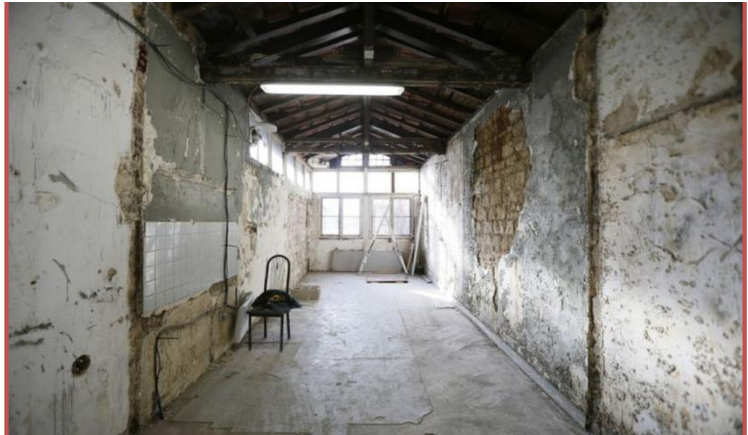
Figure 45 les travaux pour espaces de cafeteria source site le parisien
