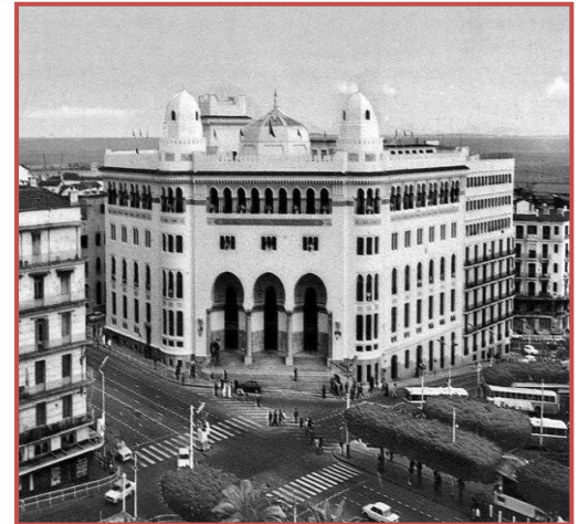
Figure 6: La grande poste d'Alger
