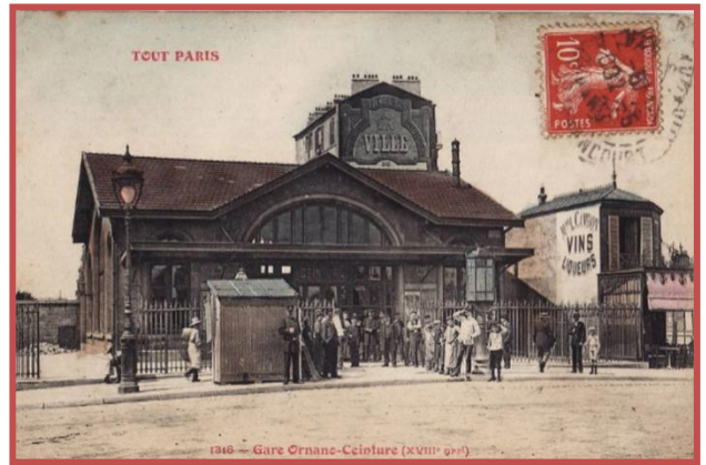
Figure 47 la façade principale de la gare Ornano en 1902
