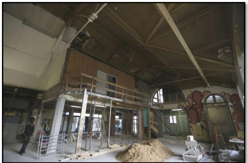
Figure 41 les travaux intérieure espace restauration bio
