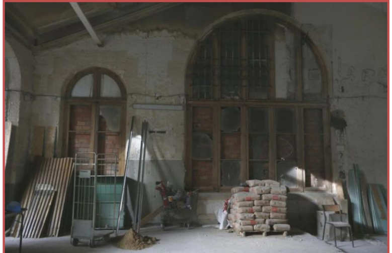
Figure 43 les travaux de la salle des pas perdu
