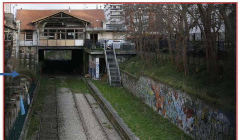
Figure 50 l'état de quais et l'espace avant la reconversion
