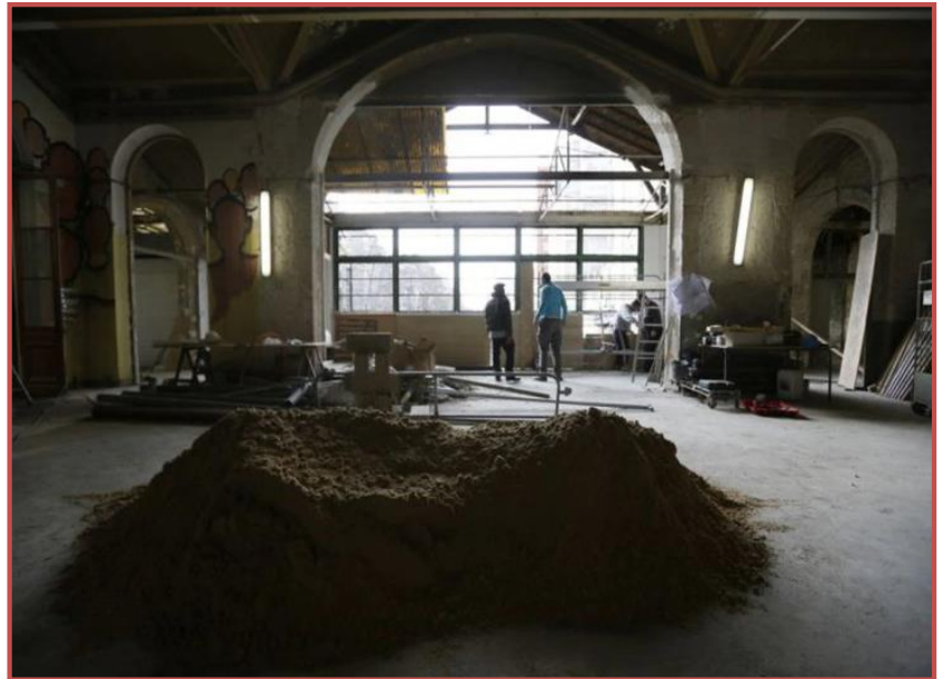
Figure 40 les travaux à l'intérieur de la gare (la verrière)
