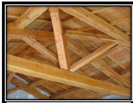
Figure 81 charpente en bois
