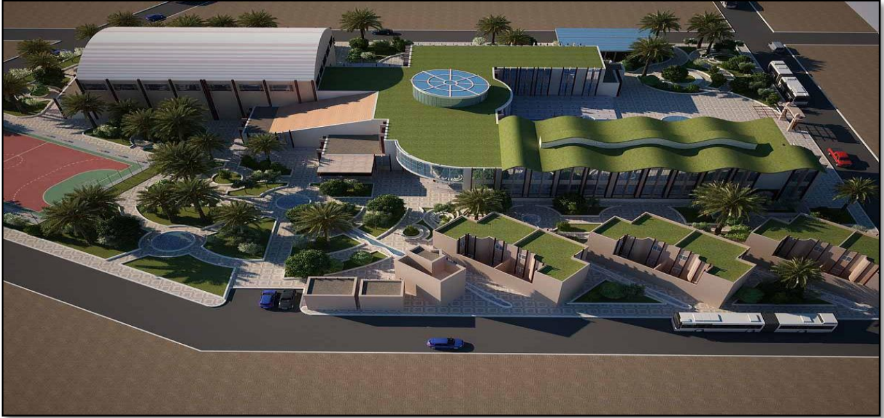
Figure55 : vue du projet la partie est
