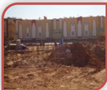
Les logements de fonction au Sud Ouest (R+2)
