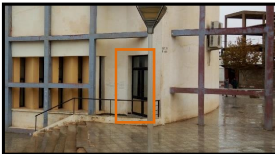
Fig69 : Issue de secours Source : auteur
