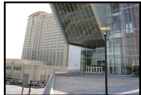
Fig.36 : Entrée secondaire au niveau du bloc orienté Nord
