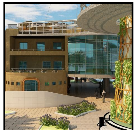
Fig. 123 : Vue de la façade nord
