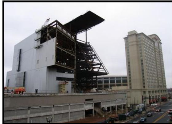
Fig. 61 Photo de la structure métallique
