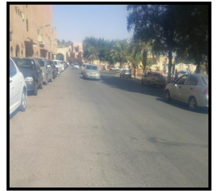
Fig. 121 : vue de la voie secondaire
