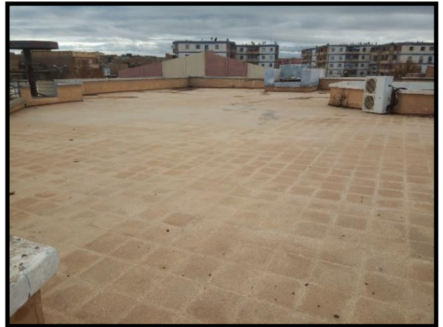
Fig. 90 : Photo montre la terrasse Source : auteur
