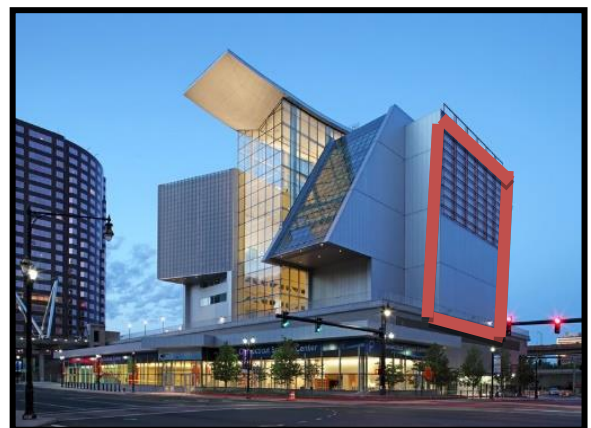
Fig. 44 : Photo de la Façade Sud
