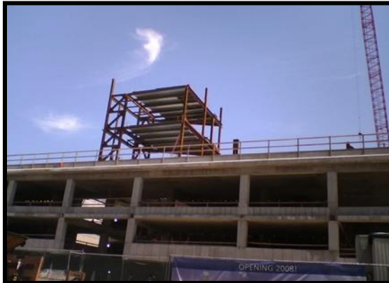
Fig.60 Photo de la structure en béton armé
