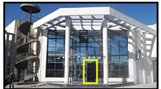
Fig70 : Entrée principale du projet Source : auteur
