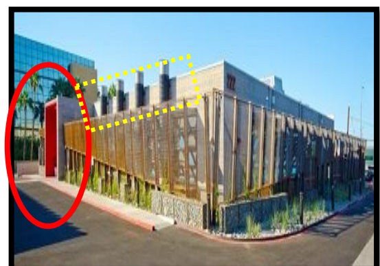
Fig.II.22 : Façades est et nord (Source : Google)
