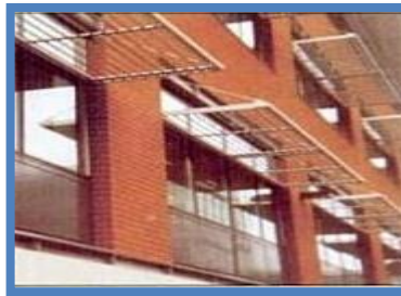
Figure 26 : Brise soleil en aluminium (R .Sigrid 2001).
