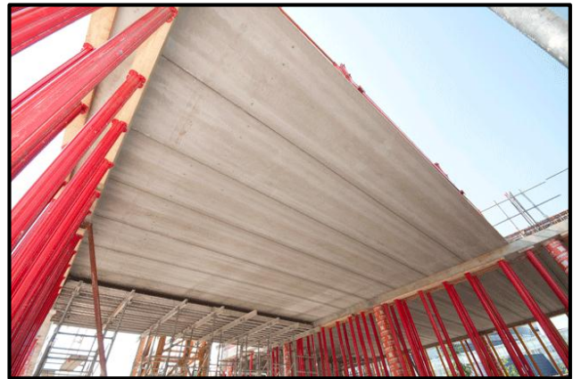
Fig. VII.04 : exemple d'exécution d'une dalle alvéolée Source : www.rector.fr
