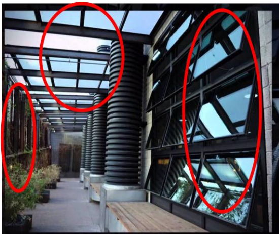
Fig. II.27 : la galerie est (Source( http://living-future.org ))
