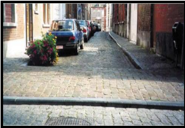
Figure II.4: Grenoble 38 : un raccord avec des éléments modulaires limite les effets de crans et de joints irréguliers. Source : fiche méthodologique aménagement des espaces publics, novembre 2012 p9
