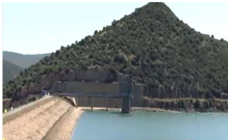
Photo .I.18 : barrage Zit El Emba
