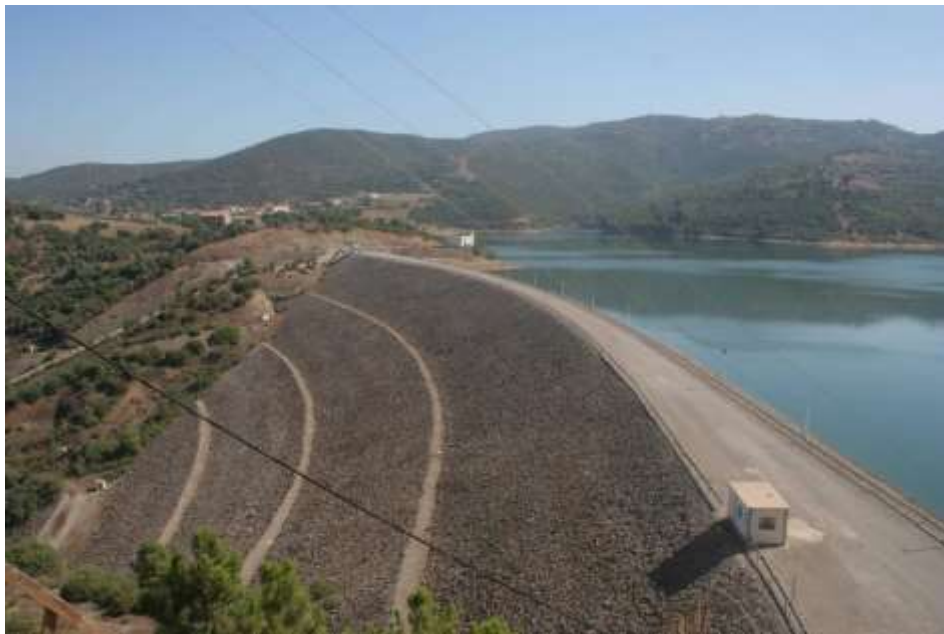
Photo .I.23 : barrage Keddara
