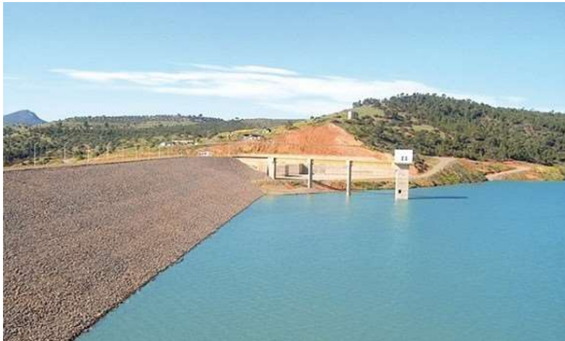
Photo .I.24 : barrage Tilesdit[3]
