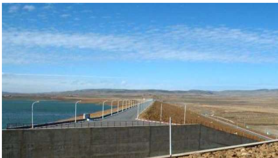
Photo .I.13 :barrage Koudait Medoura
