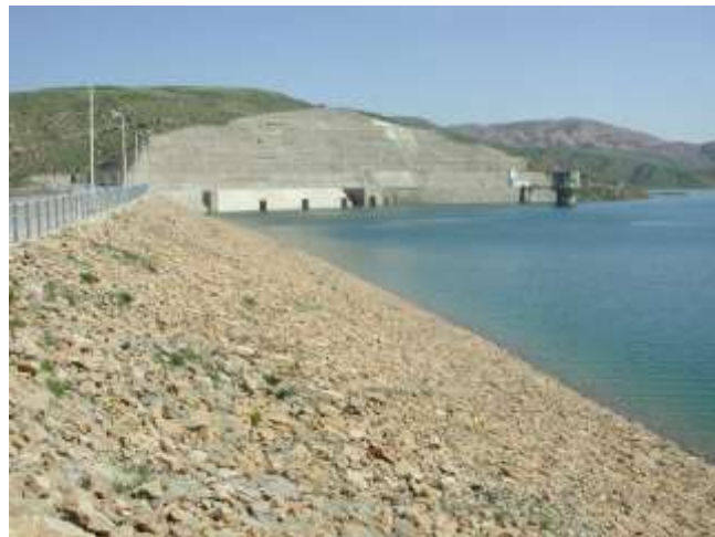
Photo .I.20 :barrage Oued Cherf
