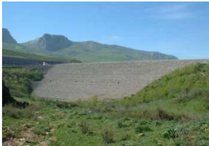
Photo.I.8 :barrage de AIN DALIA
