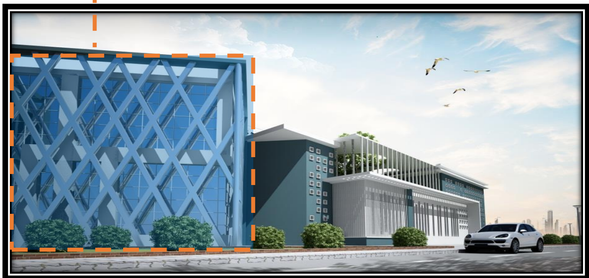
Figure 131 : utilisation des brises soleil
