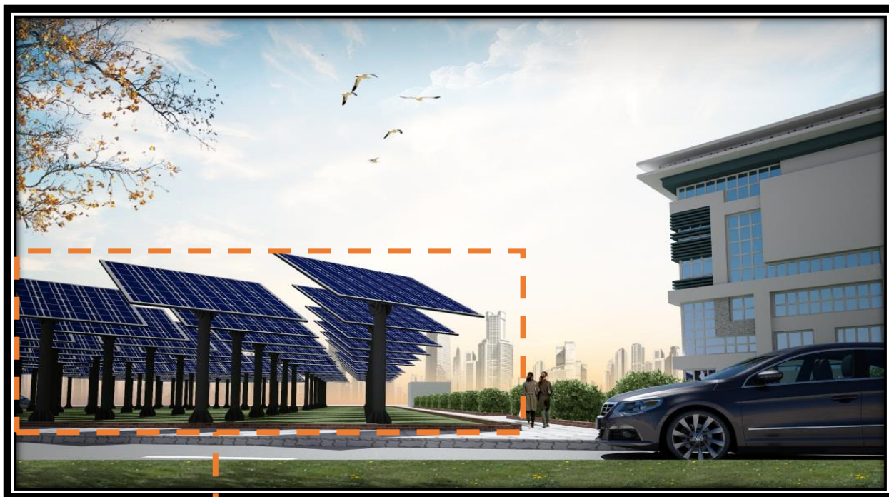
Figure 138 : vue sur partie expérimentale
