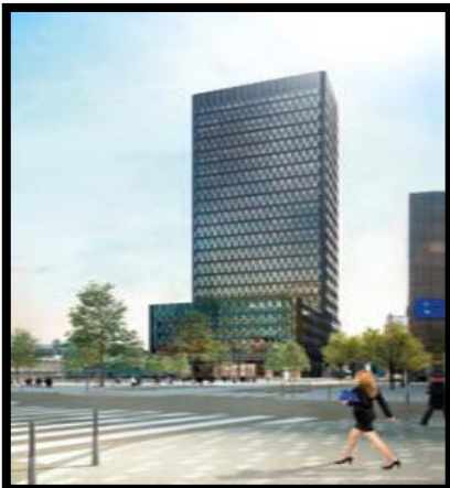
Figure 18 : la façade de latour Source: PDF PEM Part Dieu rapport conclusions CE 21/11/2021
