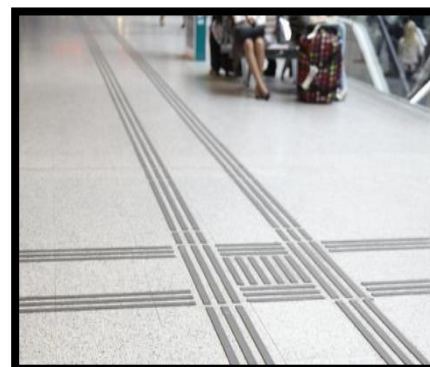
Figure 76 : Bandes de guidage. Source : https://www.sncf.com/
