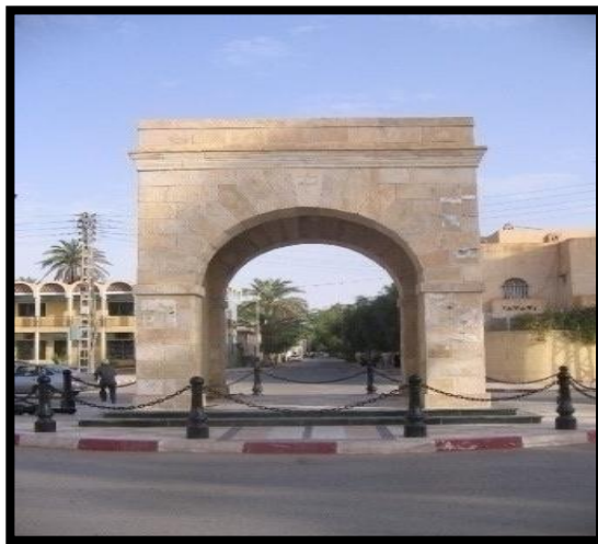
Figure n117 :Bâb dzair Source : prise par auteur 2019
