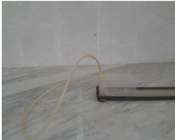
Figure II.3 : bassin de drainage
