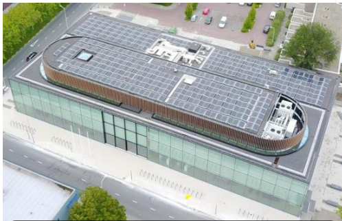
الشكل 46.1 : الألواح الكهروضوئية في المبنى المصدر: www.cepezed.nl
