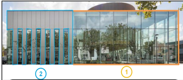
الشكل 41.1 : أنواع واجهات المبنى
