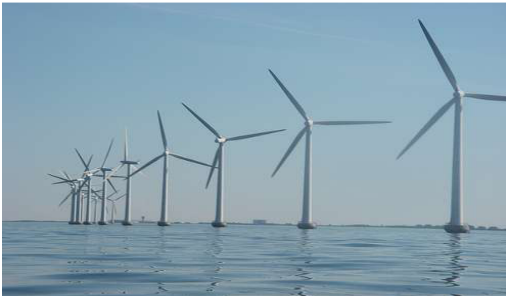
Figure I.22 Parc éolien installé dans la mer
