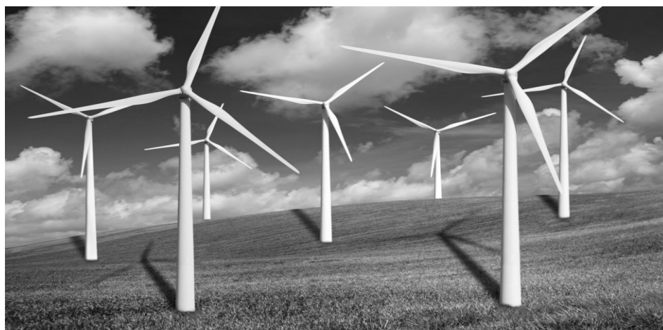
Figure I.7 Eoliennes à axe horizontal et tripales
