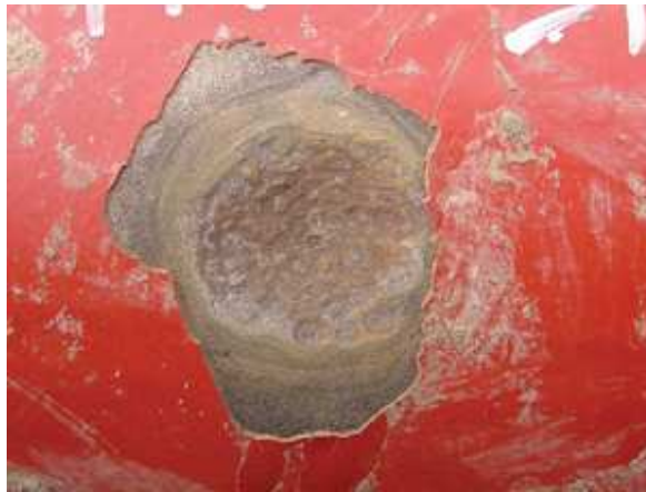
Figure II-11 : Corrosion d'un pipeline situé à proximité des lignes de transport HT
