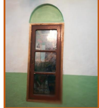
الصورة 80: صورة توضح تفاصيل النافذة الموجودة في الجهة الغربية المصدر: الباحث
