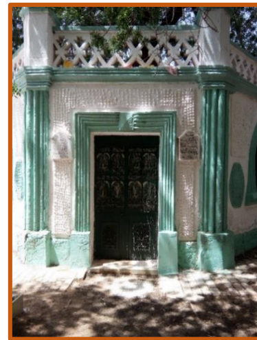
الصورة 65: منظر عام لواجهة الضريح المصدر: الباحثان
