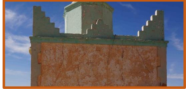
الصورة 141: تبين التتويجات المسننة المستعملة في الزوايا العليا للضريح المصدر: الباحث
