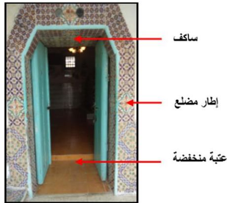
الصورة 33: تبين المدخل
