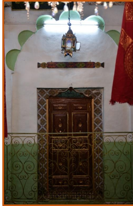
الصورة 78: صورة توضح تفاصيل الباب الشمالي المصدر: الباحث
