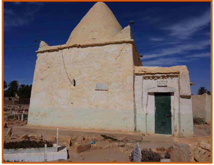
الصورة 47: منظر عام لواجهة الضريح المصدر: الباحثان
